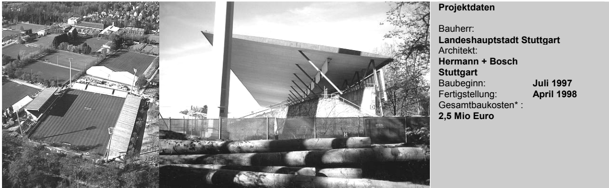
Abbildung 11: Tribünenüberdachung GAZI-Stadion, Stuttgart
