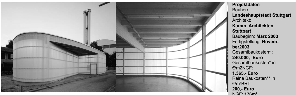
Abbildung 14: Fahrzeughalle für das Tiefbauamt, Stuttgart - Feuerbach
