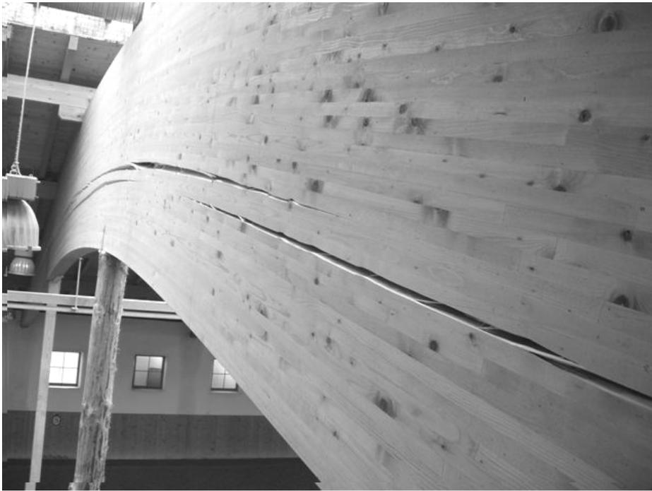
Abbildung 5: Gekrümmter Träger mit Riss
