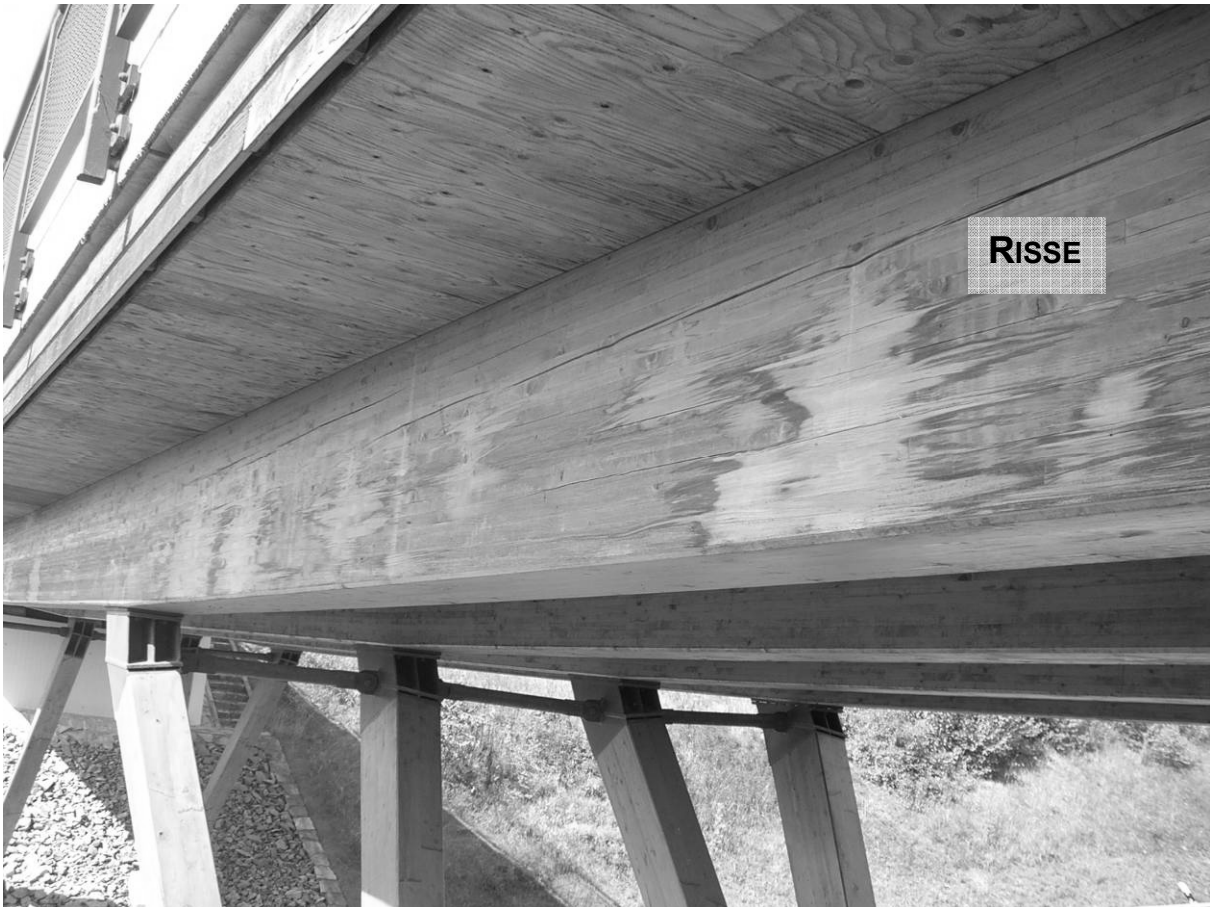
Abbildung 5: Risse Längsträger
