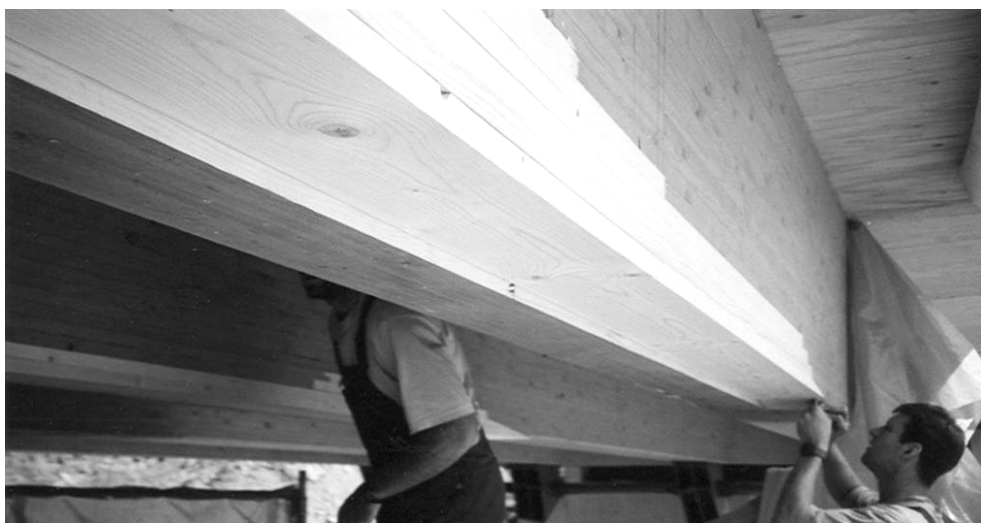
Abbildung 7, 8 und 9: Reparaturen Brücke Ruderting
