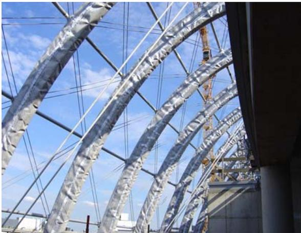
Abbildung 12: Montage Tragwerk
