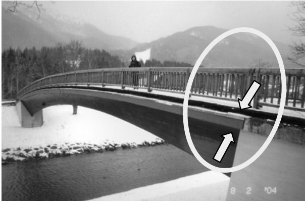
Abbildung 4: Hohlkastenbrücke Oberammergau (D)
