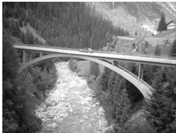
Abbildung 6-2: Straßenbrücke Innerferra (CH)
