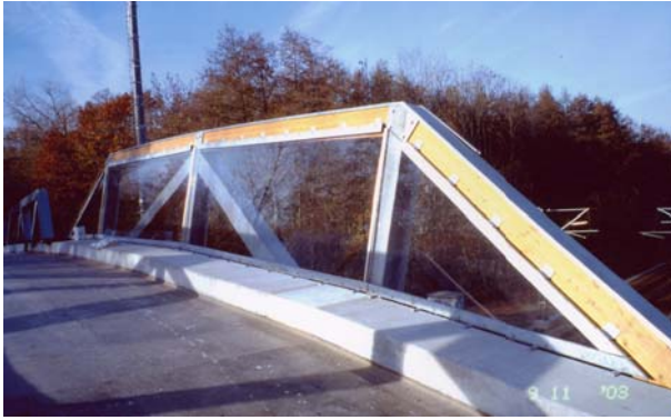
Abbildung 3: Detailansicht Bekleidung Fachwerkträger Fußgängerbrücke St. Leon-Rot (D)
