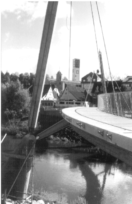
Abbildung 6-1: Brücke Wernau (Neckar) (D) im Bauzustand
