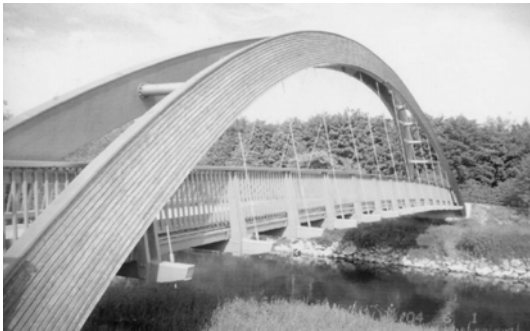
Abbildung 9: Bogenbrücke bei Altheim (D)
