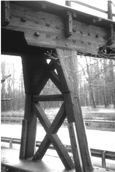
Abbildung 1: Brücke Pforzheim-West (D) Baujahr 1938
