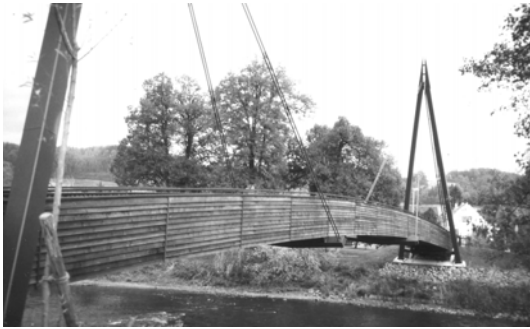
Abbildung 7: Straßenbrücke Hoyerswerda (D)
