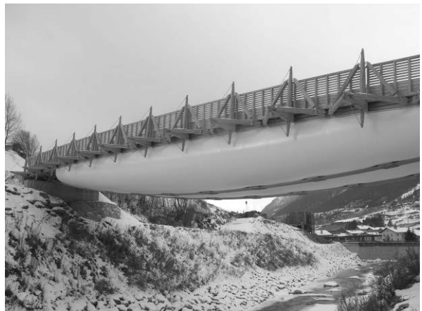
Abbildung 12: Inbetriebnahme der Membrane
