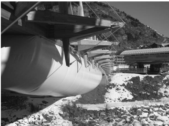
Abbildung 11: Inbetriebnahme der Membrane
