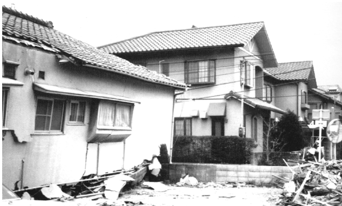
Figura 5: Terremoto di Kobe, Giappone, 1995, M=6,8. L'edificio in primo piano di più antica costruzione ha subito danni rilevanti, gli edifici sullo sfondo, moderni e realizzati con il sistema Platform Frame sono rimasti intatti [4].
