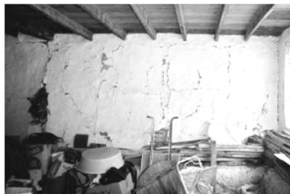
Figura 3: A sinistra: esterno di una parete di una casa Himiş all’interno della zona più colpita dal terremoto, un mese dopo l’evento. A destra: la stessa parete visibile dall’interno dove si notano le fessurazioni nell’intonaco causate dal terremoto [3].
