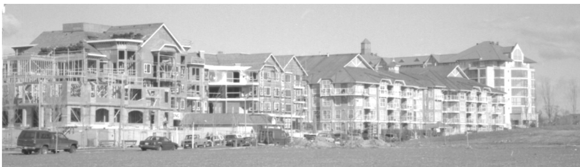
Figura 4: Un condominio di quattro piani fuori terra a Richmond, British Columbia, Canada. Zona sismica di seconda categoria
