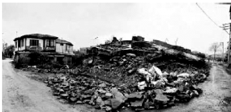
Figura 2: Edificio di cemento armato crollato presso la città di Adapazari a seguito del terremoto di Izmit, accanto ad una Casa Himiş sopravvissuta intatta [3]
