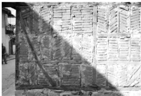
Figura 3: A sinistra: esterno di una parete di una casa Himiş all’interno della zona più colpita dal terremoto, un mese dopo l’evento. A destra: la stessa parete visibile dall’interno dove si notano le fessurazioni nell’intonaco causate dal terremoto [3].
