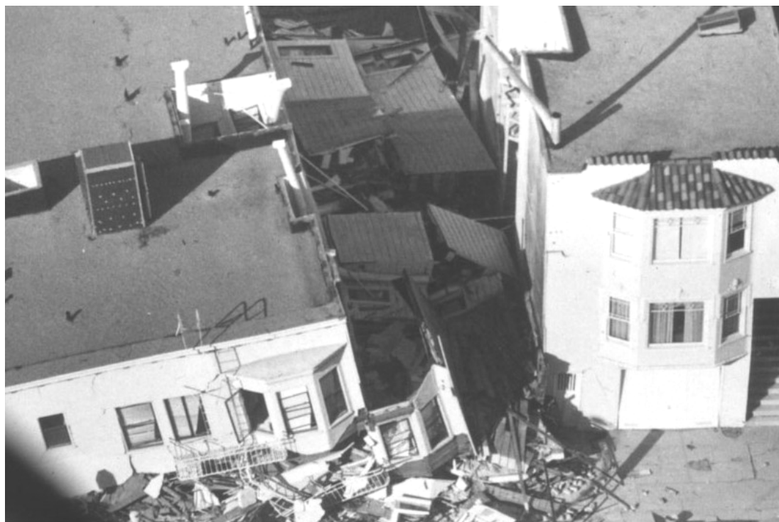
Figura 6: La fotografia illustra lo stato di due edifici pressoché identici a seguito del terremoto di Loma Prieta in California del 1989: l'edificio di sinistra è crollato quello di destra è rimasto praticamente intatto. Il motivo è imputabile probabilmente a carenze in fase di esecuzione.
