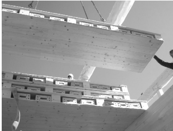
Abbildung 9: Deckenmontage
