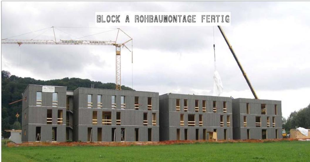
Abbildung 9: Block A Rohbaumontage fertig
