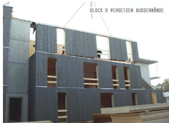
Abbildung 11: Block B versetzen der Wände
