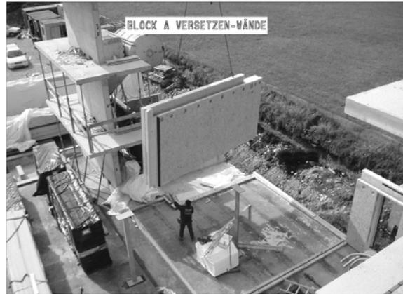
Abbildung 4: Block A ... versetzen der Wände
