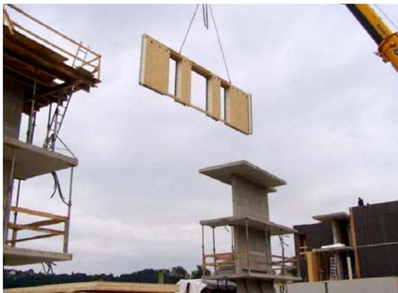
Abbildung 12: Block B versetzen der Wände
