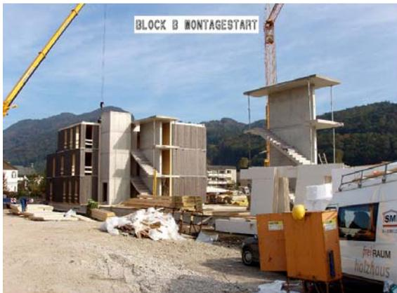
Abbildung 10: Block B versetzen der Wände
