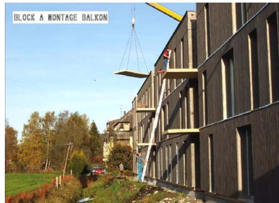
Abbildung 13: Block A einhängen der Balkonelemente
