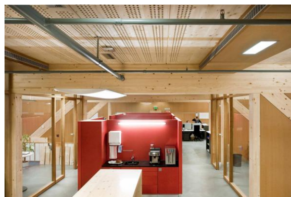
Links: LIGNATUR-Flächenelemente werden montiert. Rechts: LIGNATUR nutzt auch für das eigene Bürogebäude seine Decken- bzw. Dachelemente, hier mit Akustiklochung. (Bildquelle: LIGNATUR)
