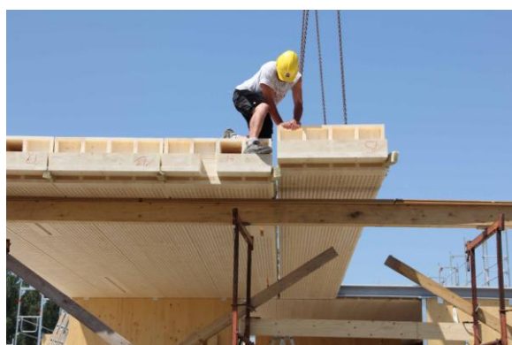
Links: LIGNATUR-Flächenelemente werden montiert. Rechts: LIGNATUR nutzt auch für das eigene Bürogebäude seine Decken- bzw. Dachelemente, hier mit Akustiklochung. (Bildquelle: LIGNATUR)
