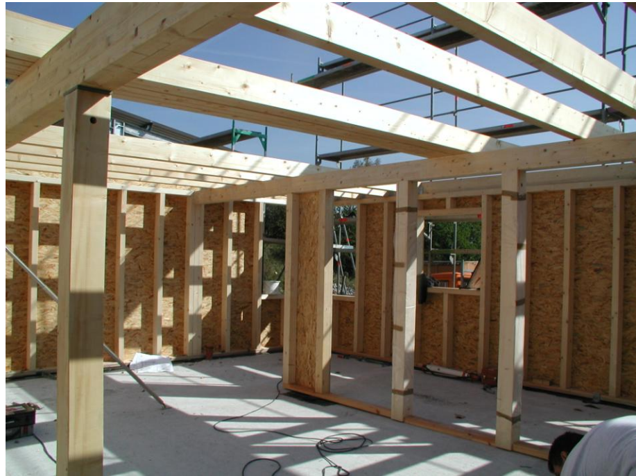
Links: Explosionszeichnung eines klassischen Holzrahmenbaus. Rechts: Montierte, einseitig offene Holzrahmenbau-Elemente. Die Wärmedämmung wird vor Ort eingelegt. (Bildquelle: Klumpp Holzbau)
