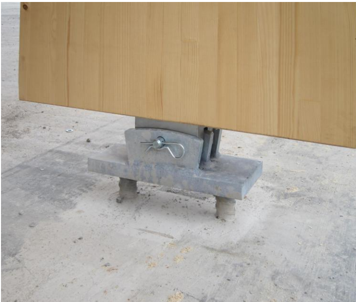
Abb. 9: Stützenschuh Hauptriegel Halle
