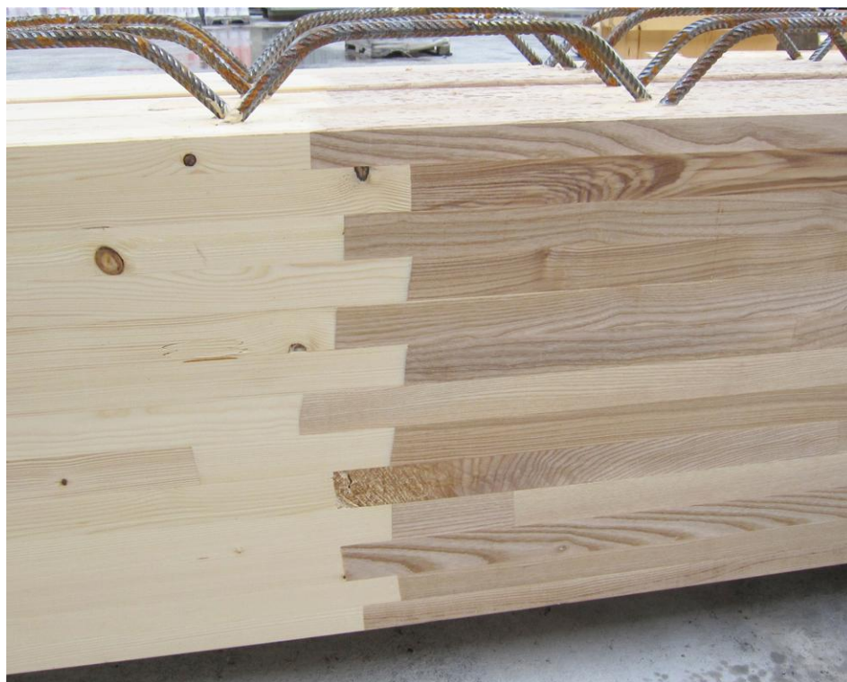
Abbildung 7: BSH Träger in Fichte und Esche, mit Bügel für HBV Decke
