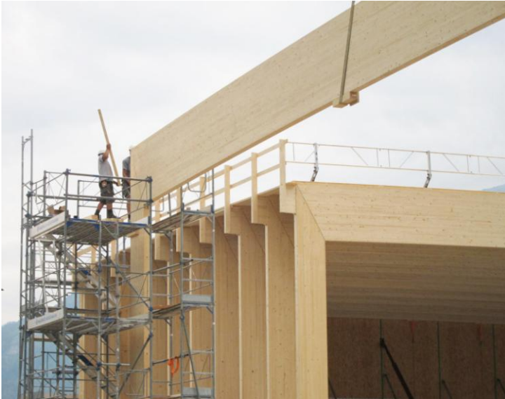
Abbildung 8: Aufrichten der Halle mit Hilfe zweier Gerüste um eine stehende Montage zu ermöglichen. Die Trägerbreite von 140 mm liess das liegende Zusammenbauen nicht zu.
