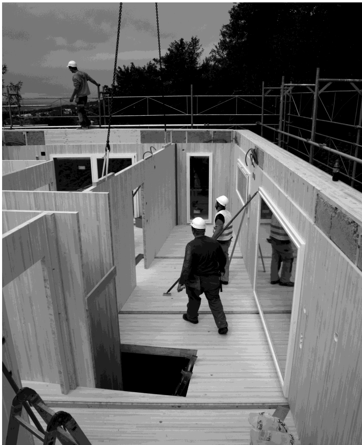
raumHaus «Haus am Wald» –Sorgfalt beim Aufrichten zum Schutz der Sichtoberflächen
