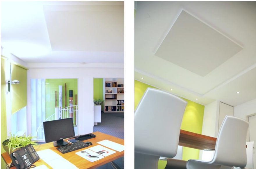
Abb. 17 + 18 Raumakustik als Deckenfeld & farbige Wand Geschäftshaus in Bad Homburg
