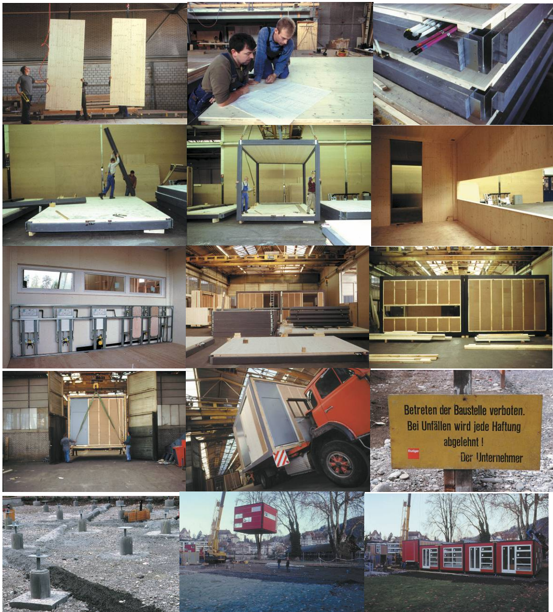
Abbildung 4: Modular-Thun, ein Kindergartenpavillon entsteht... Fotos © bauart
