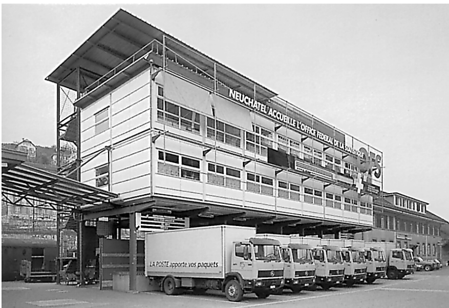
Abbildung 3: Südfassade Provisorium, Neuchâtel / © Fotos: Christine Blaser, Bern
