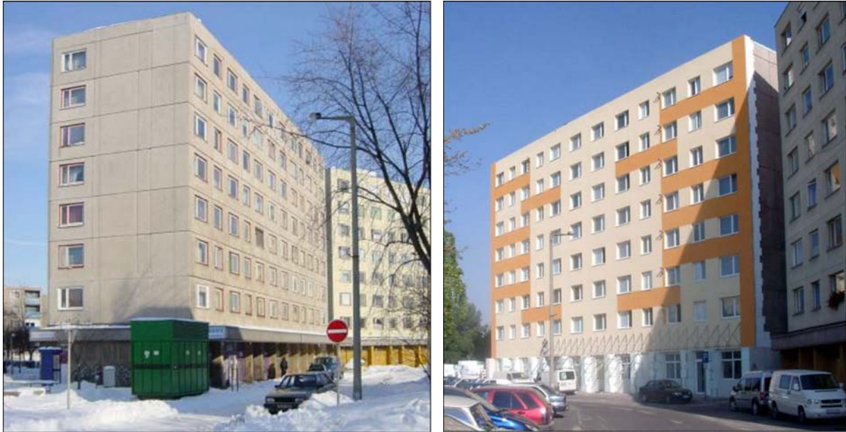
Abbildung 9: Plattenausanerung mit Passivhauskomponenten in Ungarn (Projekt Solanova; Leitung WZ III der Universität Kassel)
