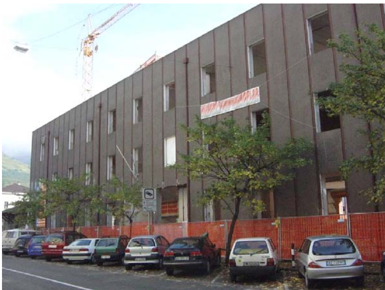
Abbildung 7: Altes Postgebäude bei Hauptbahnhof in Bozen vor der Sanierung
