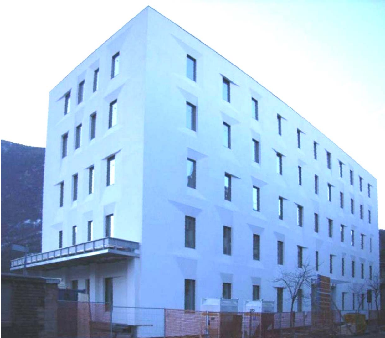
Abbildung 8: Eines der eindrucksvollsten Passivhaus-Projekte in Italien: Das „Landeshaus“ (zu deutsch Ministerium) des Landesrates für Energie in Bozen, direkt am Hauptbahnhof. Der Architekt Michael Tribus hat die „Alte Post“ in ein hochmodernes Energiesparhaus umgewandelt. &0 kW Heizleistung reichen aus, um dieses Bürogebäude zu beheizen – früher brauchte man das für ein Einfamilienhaus.
