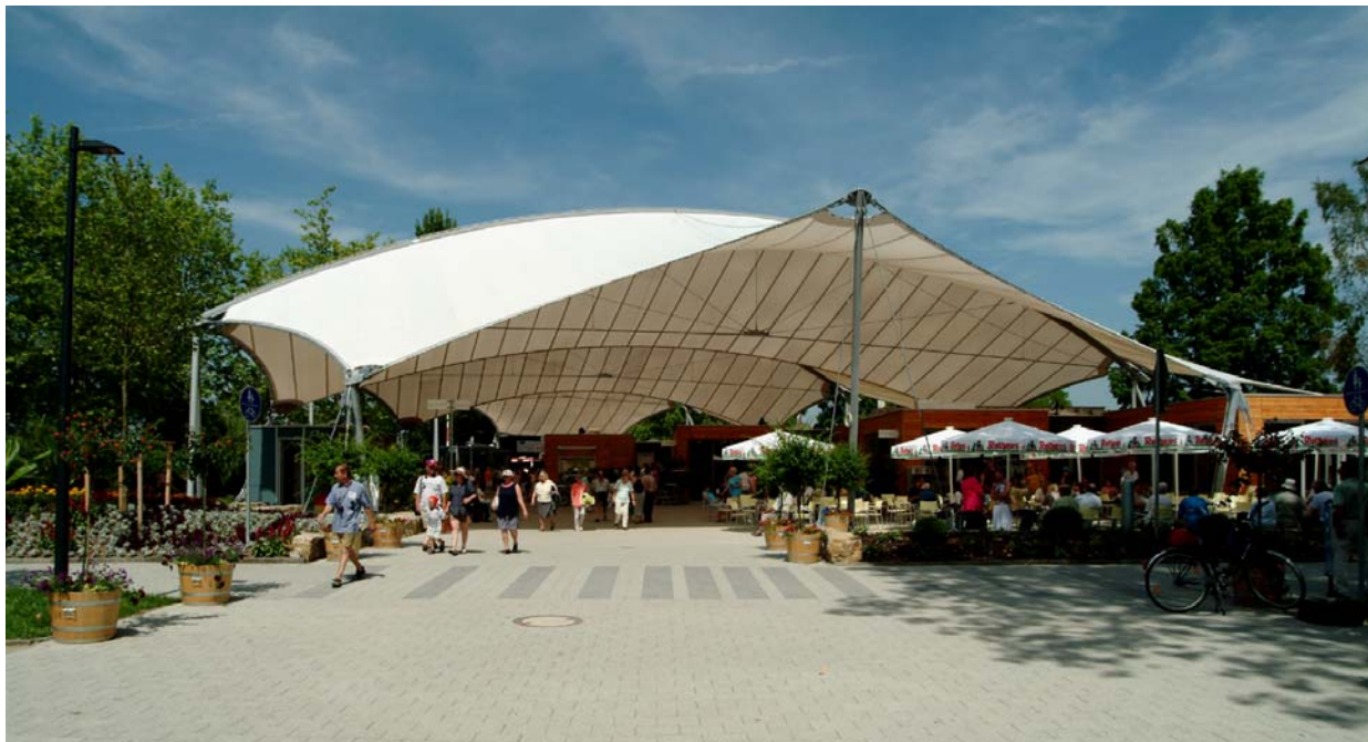
Abbildung 11: die „Eingangshalle“ mit dem durch Holzkuben gebildeten Platz
