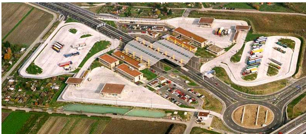
Abbildung 1: Luftaufnahme mit dem Gesamtüberblick. In der Bildmitte die Personenabfertigung mit Fahrbahndach und eingeschossigen Bauten, in zweiter Reihe die zweigeschossige Warenabfertigung mit Spediteurgebäude, dann der Zollhof mit Güterrampe, Kontrollpunkt Lkw und Lkw-Stauraum
