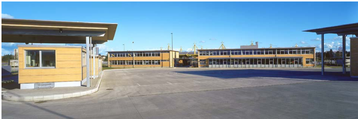
Abbildung 6: Zollhof, links Kontrollpunkt, Mitte Spediteure und Warenabfertigung, rechts Güterrampe
