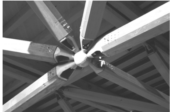
Abbildung 17: Detail Knotenausbildung
