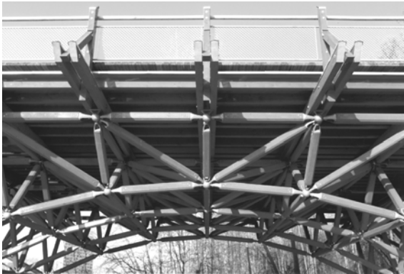
Abbildung 16: Brücke München-Thalkirchen, Raumfachwerk
