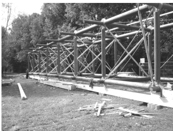
Abbildung 8: Isarbrücke Oberföhring, Vormontage
