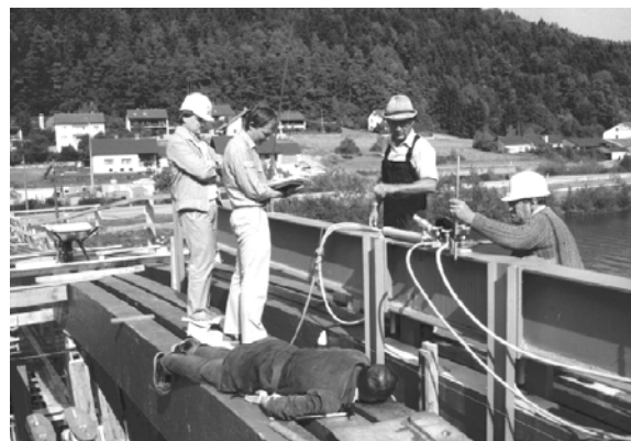
Abbildung 25: Biegezugtest nach Fertigstellung der Stöße
