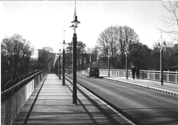
Abbildung 14: Straßenbrücke aus Holz über die Isar
