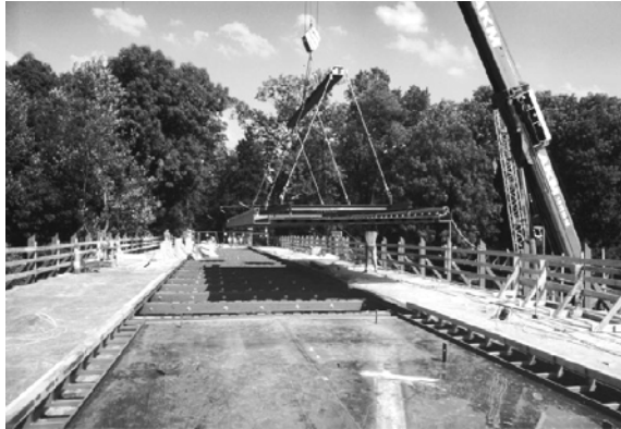
Abbildung 18: Brücke München-Thalkirchen, Fahrbahnunterbau aus Stahlblech
