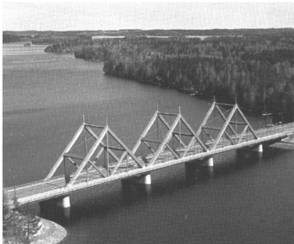
Abbildung 10: „Vihantasalmi-Brücke“ in Finnland, Haupttragwerk Holz und Stahl
