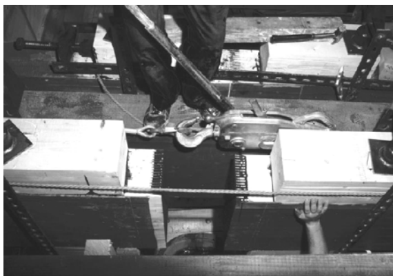
Abbildung 24: Spannbandbrücke Essing, Ausführung der Keilzinkenstöbe
