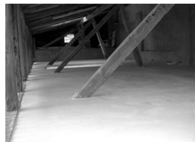
Abbildung 18, 19 und 20: HBV-Sanierungssystem - vor und nach dem Betoniervorgang
