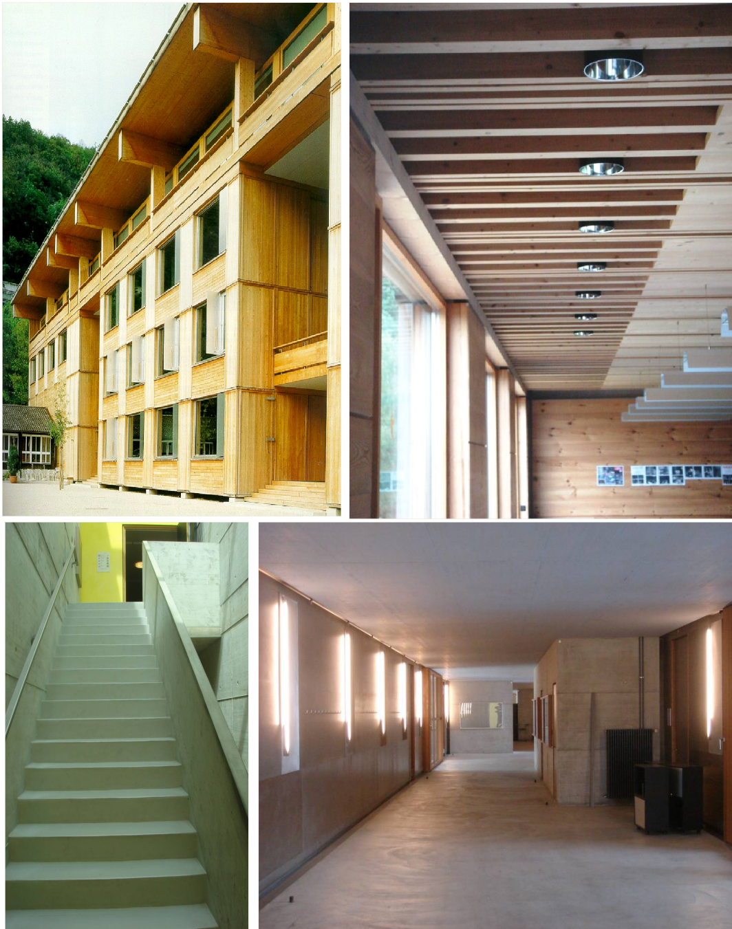
Abbildung 1: Oben: Links im Bild eine Aussenansicht des Gebäudes und rechts ein Vorlesungssaal von innen. Unten: Treppenhaus (links) sowie Korridore (rechts) sind aus brandschutztechnischen Gründen in Stahlbeton gebaut. (Quelle: Fotografiert von Hanspeter Kolb, Mitarbeiter der BFH AHB).
