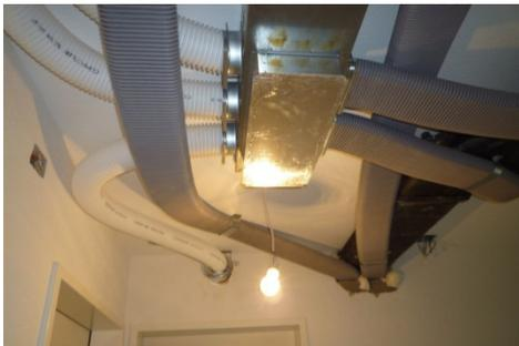
Kanal und Leitungsführung in der Dämmung bzw. in der Primärstruktur des Gebäudes nur wählen, wenn nicht anders lösbar.
