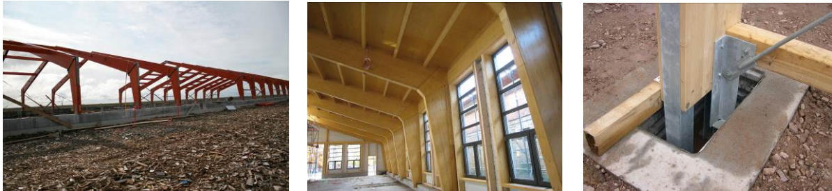
Abbildung 14, 15, 16: Rahmenecke F0. Rahmenecke F30. Stützeinspannung (Fotos: Ticomtec, Schaffitzel, Gröber).
