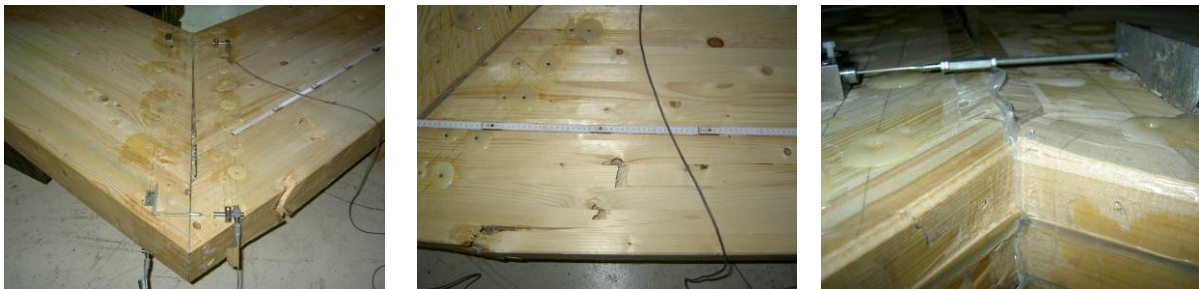
Abbildung 29, 30, 31: Rahmenecke IV-12 mit Kombination aus Blockscheren und Zugversagen im Zugbereich sowie Rissverlauf durch Bohrung. Rahmenecke IV-12 mit Detailaufnahme von Rissen in der Zugzone. Rahmenecke IV-12 mit großen Verformungen und Aufwölbungen in der Druckzone.
