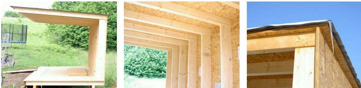
Abbildung 32, 33, 34: Experimentalbau Fahrradunterstand mit einer Auskragung der Sparren von 300 cm. Detailansicht des Anschlusses Stütze an Sparren – ästhetisch schlanke Querschnitte (Stütze 4/22 cm, Sparren 8/14 cm) mit nicht sichtbaren, innen liegenden versteckten Verbindungsmitteln. Detailansicht der Ecke im Winter – OSB-Beplankung der Rückwand und des Daches sowie Bitumenbahn als Dachabdichtung.
