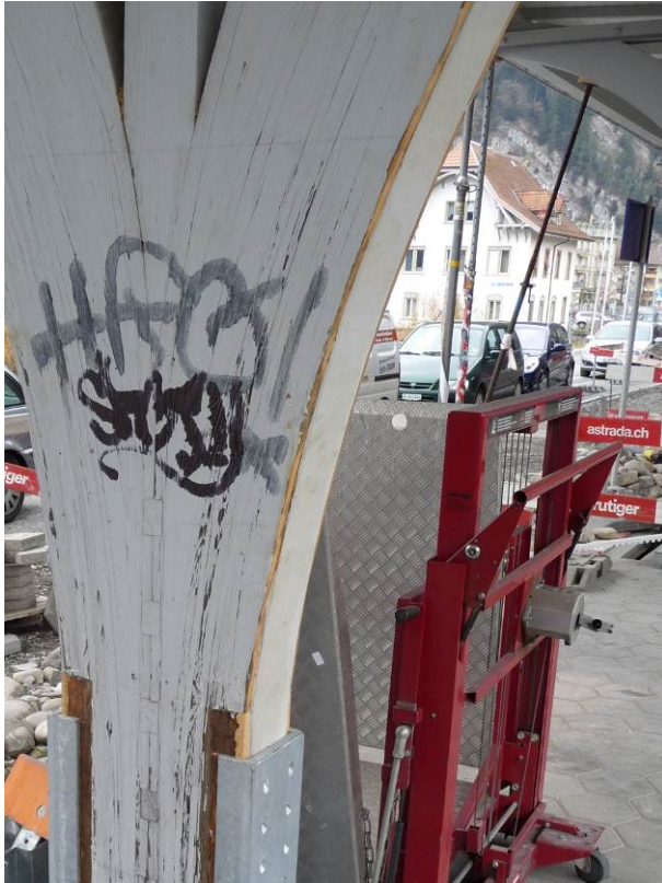
Abbildung 18: Zweilagige Kohlefaserlamelle zur Biegezugverstärkung.
