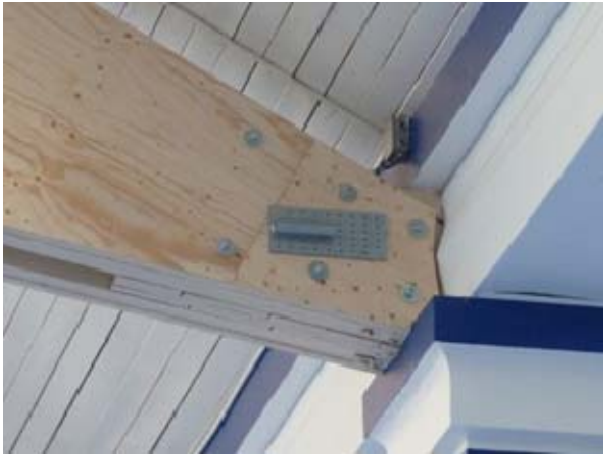
Abbildung 13: Knotenplatten aus Furniersperrholz sorgen für die Einleitung der Kräfte von der Zugstange in die Ober- und Untergerute.
