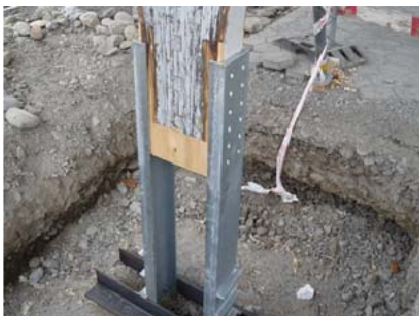
Abbildung 16: Einspannung vor dem Betonieren
