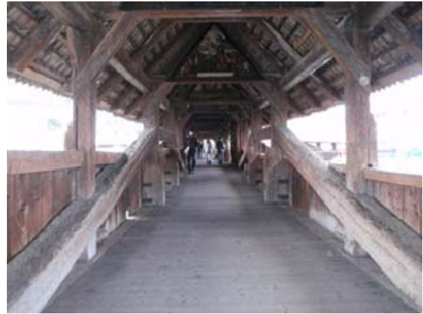
Abbildung 3: Innenansicht Brückenfeld 2 erbaut 1785.
