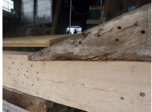
Abbildung 7: Alter Strebenversatz mit neuem Zuggurt vor der Montage des Schlitzbleches und der Stabdübel.
