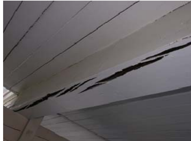
Abbildung 11: Grosse Schwundrisse in den Pfetten
