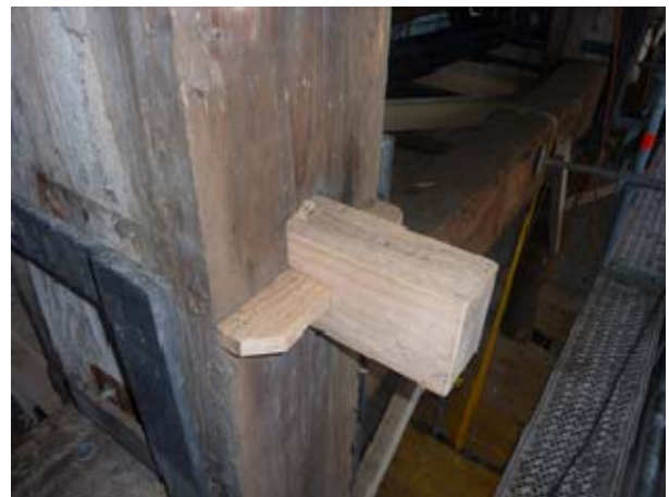
Abbildung 9: Wo möglich wurden wieder die traditionellen Verbindungsmittel eingesetzt
