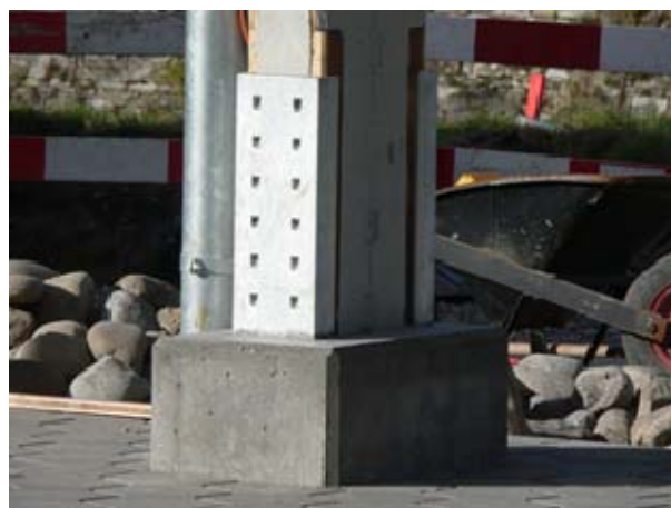
Abbildung 17: Fertiger Binderfuss mit Sockel
