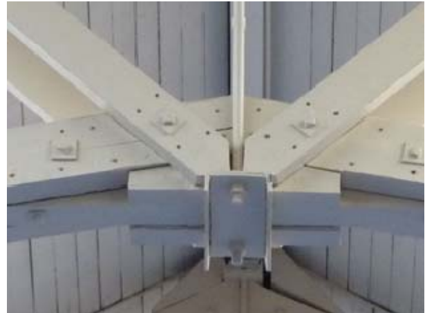
Abbildung 14: Ertüchtigung der Anschlüsse der Diagonalen mit kreuzweise eingedrehten Vollgewindeschrauben.
