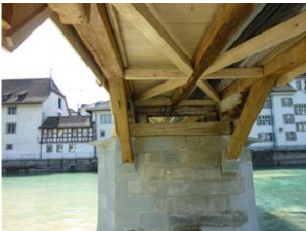
Abbildung 8: Brückenuntersicht nach der Sanierung mit rekonstruierten Bugstreben und ergänzter Queraussteifung.
