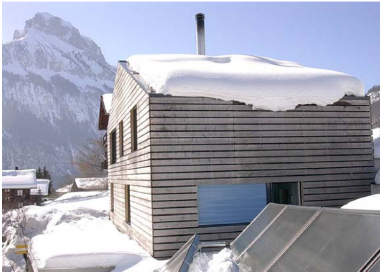
Abb. 9 Einfamilienhaus mit unbelüftetem Blechdach in Berggebiet; Holzelementkonstruktion mit Zusatzdämmung
