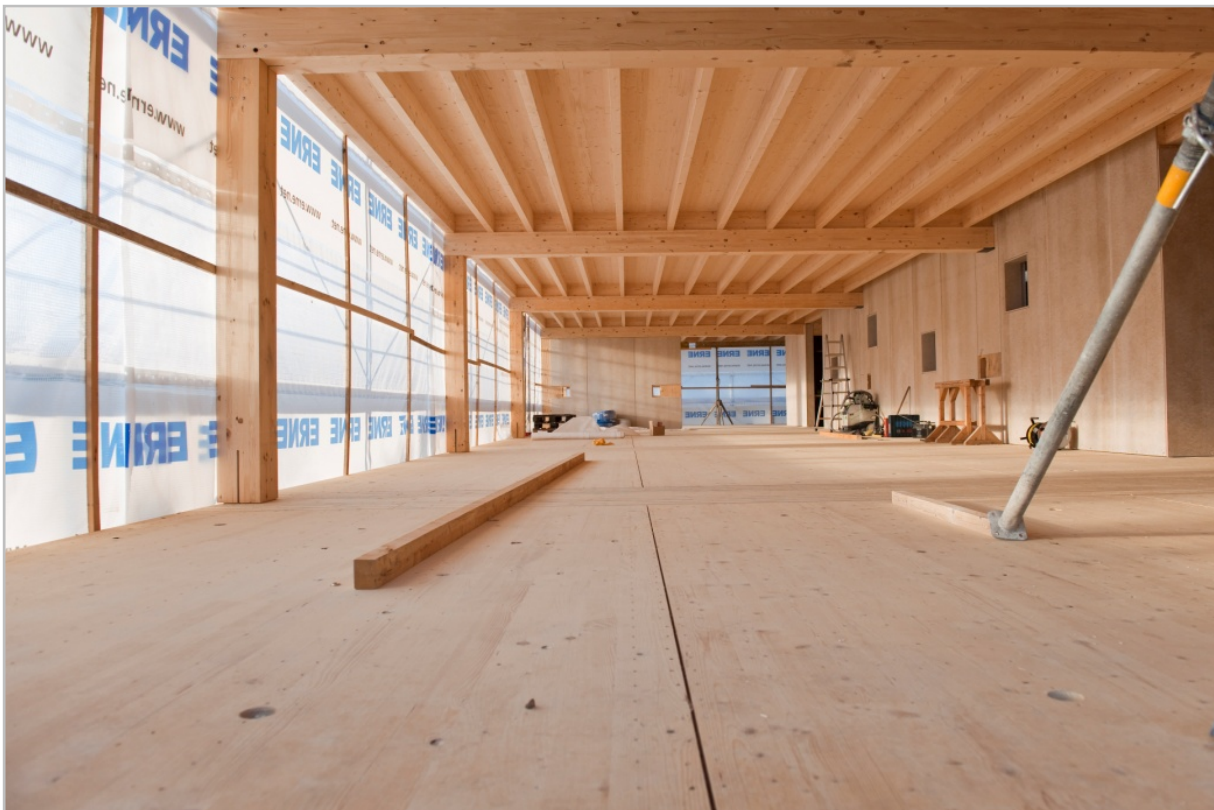
(Bild 24), Erweiterung des Bestandes, Tragkonstruktion in Holz
