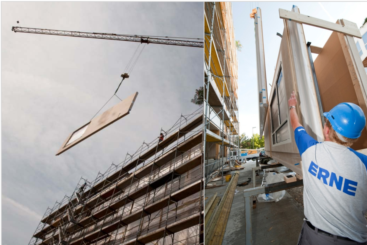
(Bild 25+26), Montage eines Fassadenelementes
