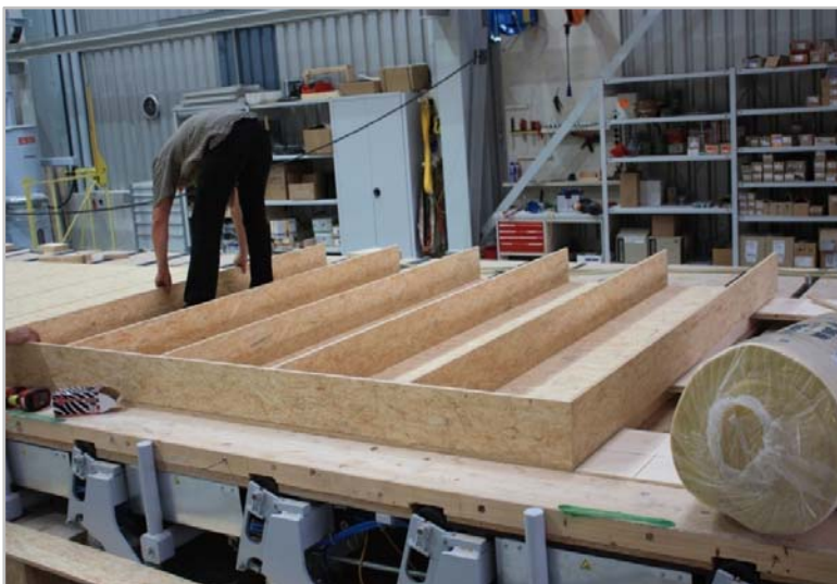
(Bild 17), Einlegen der Ständer
