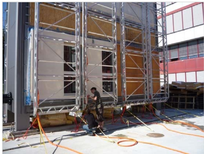
(Bild 21), Fassadenprüfstand Luzern
