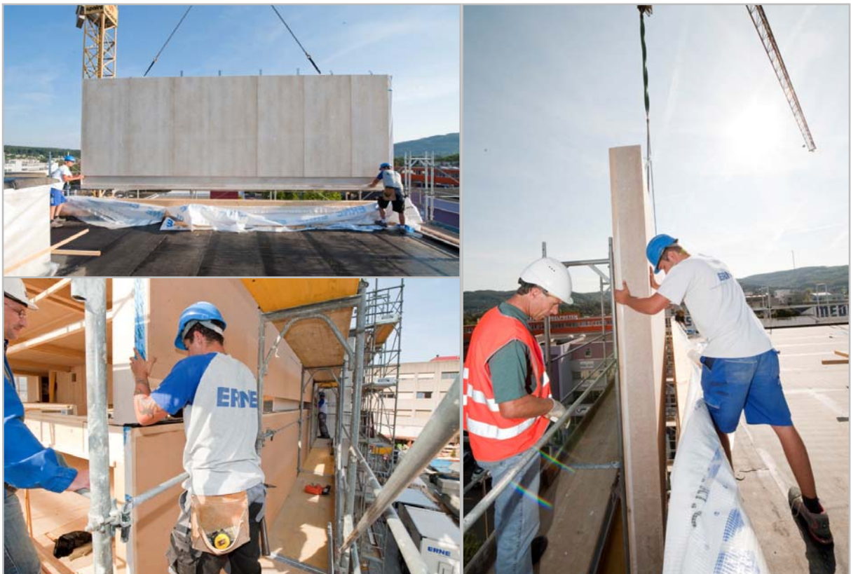
(Bild 27), Montage der Aufstockung in Elementbauweise
