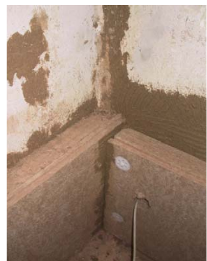
Abb. 9 a – b: Pavadentro Innendämmplatten mit Funktionsschicht für den Kapillartransport. Fotos: Wilfried Walther und Robert Borsch-Laaks
