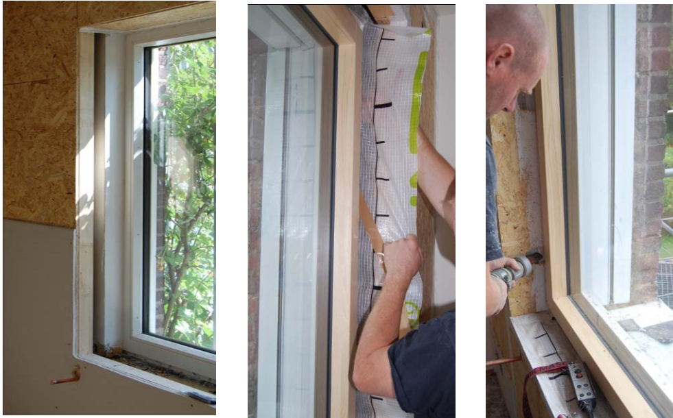
Abb. 8 a-c: Ausführung der Innendämmung à la Holzrahmenbau. Fotos: Robert Borsch-Laaks
