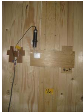
Abb. 10: Verschiebung der sich in einer Ebene stossenden Wandelemente
