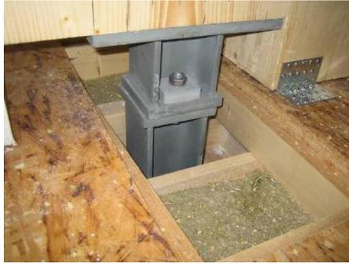
Abbildung 10: Für die Kraftübertragung geeignete Verankerung (Bild Renggli)
