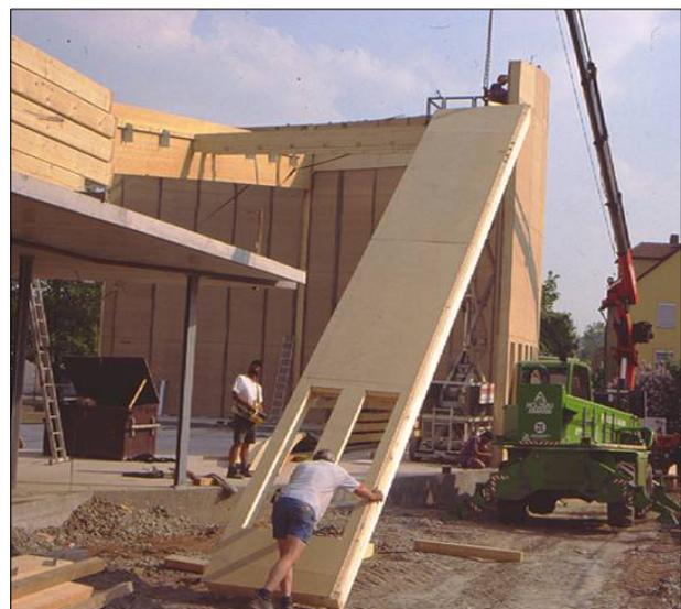
Abbildung 22: Montage eines Tafelelementes
