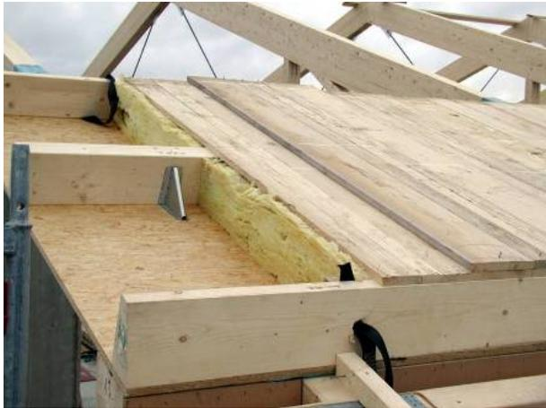
Abbildung 16: Luftdichte Ausbildung einer raumseitigen Dachscheibe, Aussenansicht
