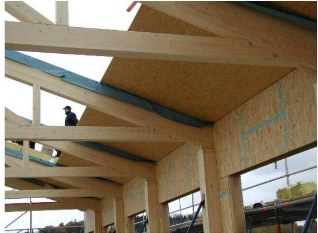
Abbildung 17: Luftdichte Ausbildung einer raumseitigen Dachscheibe, Innenansicht
