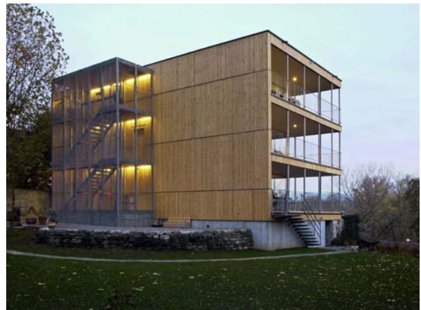
Abbildung 2: Nordfassade mit Treppenhaus
