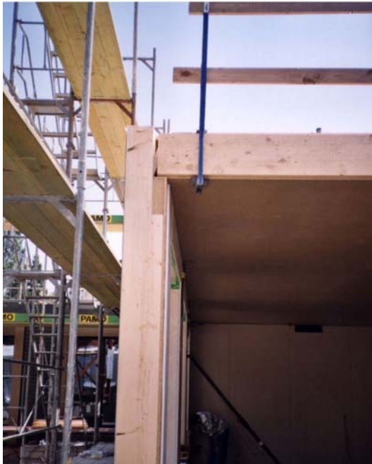
Abbildung 6: Übergang Geschosdecke - Aussenwand
