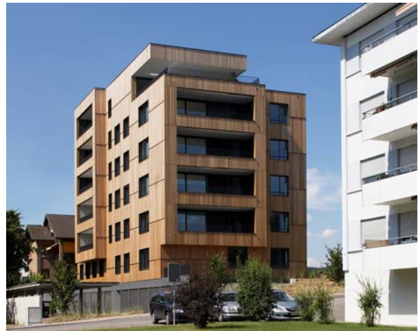
Abbildung 11: MFH Holzhausen, Steinhausen
