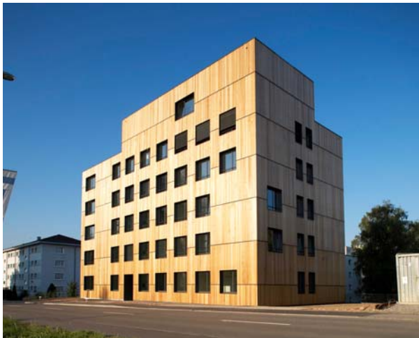
Abbildung 10: MFH Holzhausen, Steinhausen
