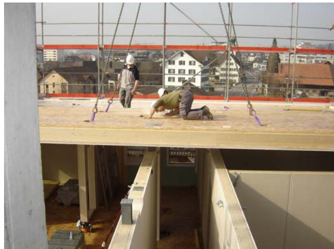
Abbildung 5: MFH Holzhausen, Steinhausen
