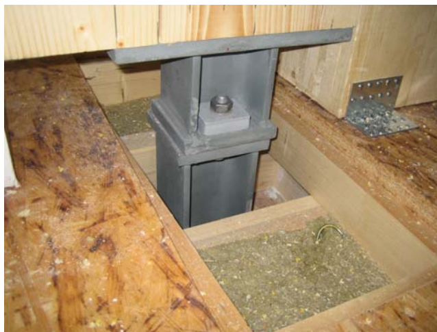
Abbildung 15: Ausführung der Verbindung von aussteifenden Wänden
