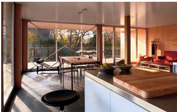
Abbildung 3: Innenansicht mit Aussteifungskreuz
