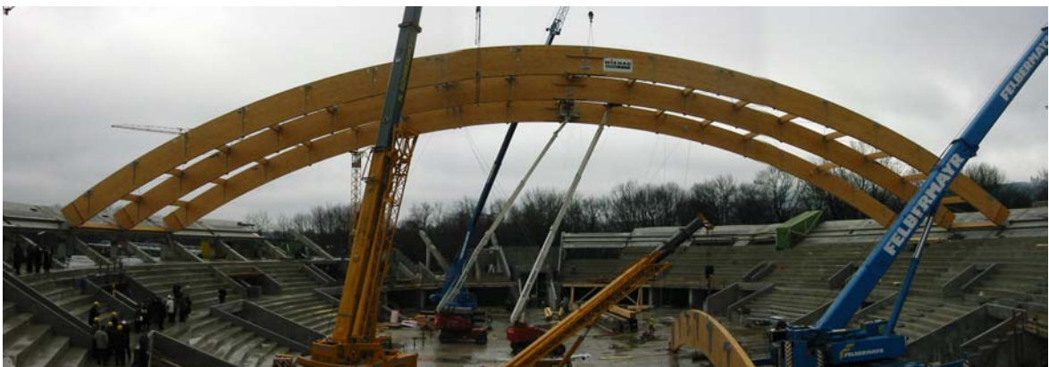
Abbildung 10 Montage Salzburg Arena
