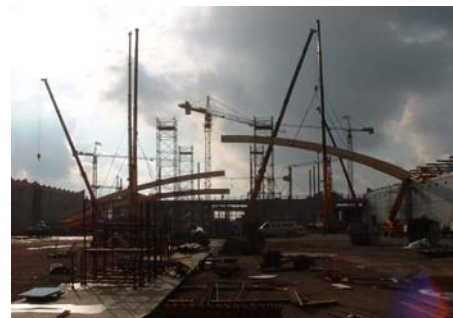
Abbildung 4 Be- Abbildung 5 Montagebeginn Baustelle war 04.12.2002
