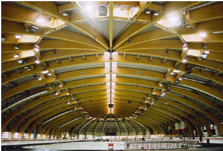
Abbildung 2 Eisschnelllaufhalle Erfurt innen
