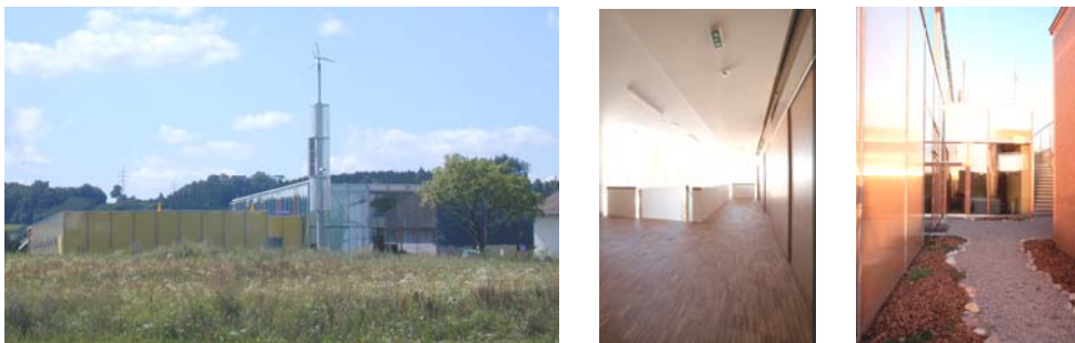
Abbildung 7: Betriebsgebäude Schlossgangl A-Steyr, Architekt Walter Unterrainer, Bildquelle: Walter Unterrainer
