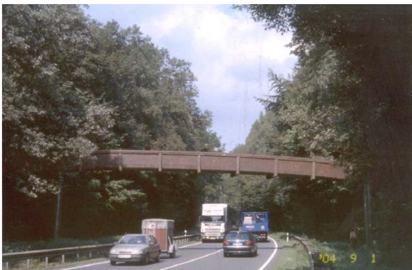
Abbildung 14: Fussgänger- und Radwegbrücke Münster (1962)
