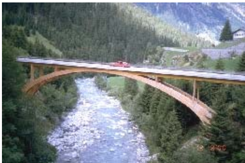
Abbildung 1: Strassenbrücke über den Averser Rhein bei Innerferrera (CH)
