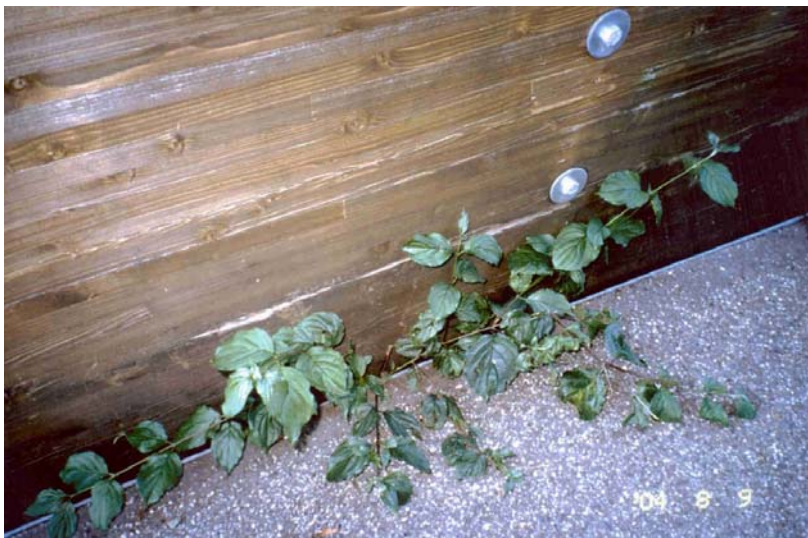
Abbildung 13: Fussgänger- und Radwegbrücke Leutkirch (1996)
