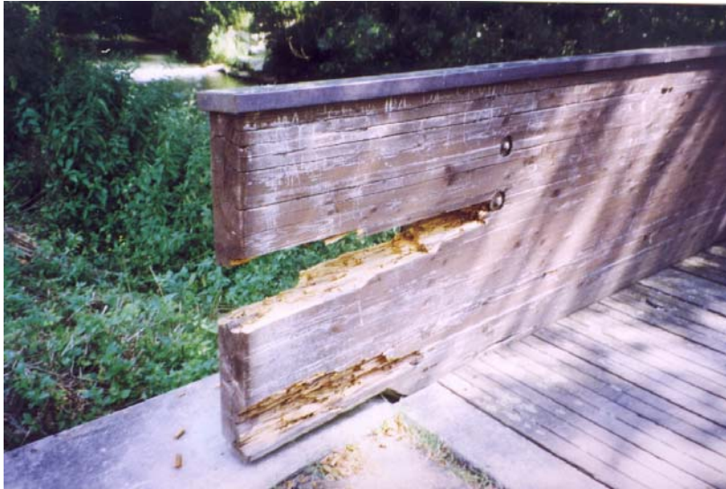
Abbildung 9: Fussgänger- und Radwegbrücke Waibstadt (1983)
