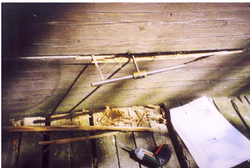
Abbildung 11: Fussgänger- und Radwegbrücke Waibstadt (1983)
