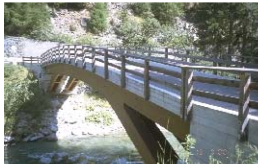
Abbildung 2: Crestawaldbrücke zu Militärdepot bei Sufers (CH)
