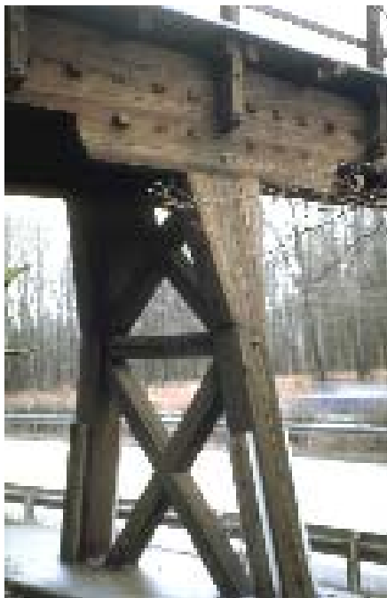
Abbildung 3: Ehem. Fußgängerbrücke über die BAB 8 bei Pforzheim-West
