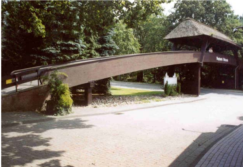
Abbildung 15: Fussgänger- und Radwegbrücke Walsrode (1972)
