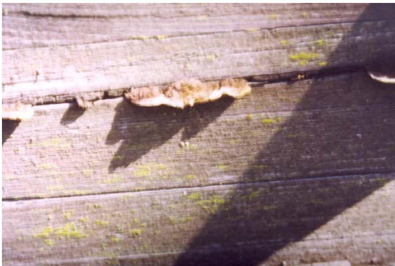
Abbildung 10: Fussgänger- und Radwegbrücke Waibstadt (1983)
