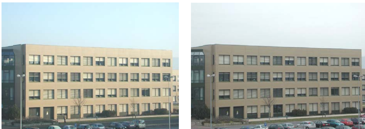
Figure 2: Utilisation des stores d'un bâtiment des bureaux. A gauche, 24 février 2003, jour ensoleillé, à droite, le 27 février, jour voilé. Les gains solaires comptabilisés dans un bilan thermique ne seront jamais réalisés et l'indice de dépense d'énergie réel sera supérieur à l'indice prévisionnel.
