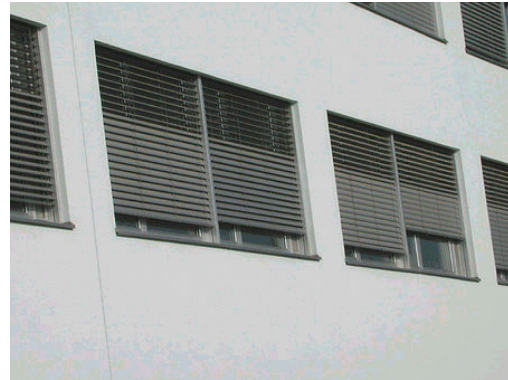
Figure 6: Les stores de la façade de la nouvelle partie de l'EPFL donnent la possibilité à l'occupant d'utiliser les lamelles du haut différemment des lamelles du bas. La lumière du haut gêne beaucoup moins le travail sur ordinateur. Ce système limite l'utilisation de l'éclairage artificiel lorsque les stores sont baissés
