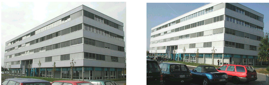
Figure 3: Utilisation des stores sur une façade Est un jour couvert de septembre à 9:40 (gauche) et un jour ensoleillé à 11:30 (droite). Si nous comptons les stores ouverts, l'efficacité de la protection solaire est de moins de 75%. En comparant la position des stores un jour voilé et un jour ensoleillé, nous pouvons constater que le rayonnement solaire n'est pas le paramètre prédominant qui motive les occupants à changer la position du store.
