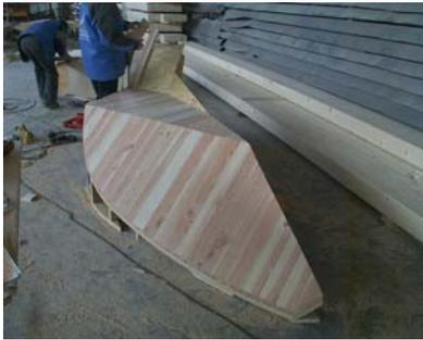
Schalung für Betonteile
