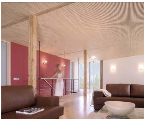
Abbildung 6: Edles, schlichtes Oberflächendesign mit Oberflächen in astreiner Weisstanne, hier mit Akustikprofilierung „alpha“
