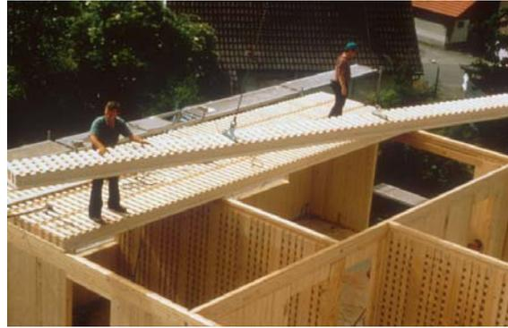
Abbildung 2: Montage der Deckenstreifen
