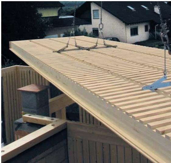
Abbildung 4: Grossformatig (max. 2,40 m x 18,00 m) vormontierte Elemente sparen Montagezeit
