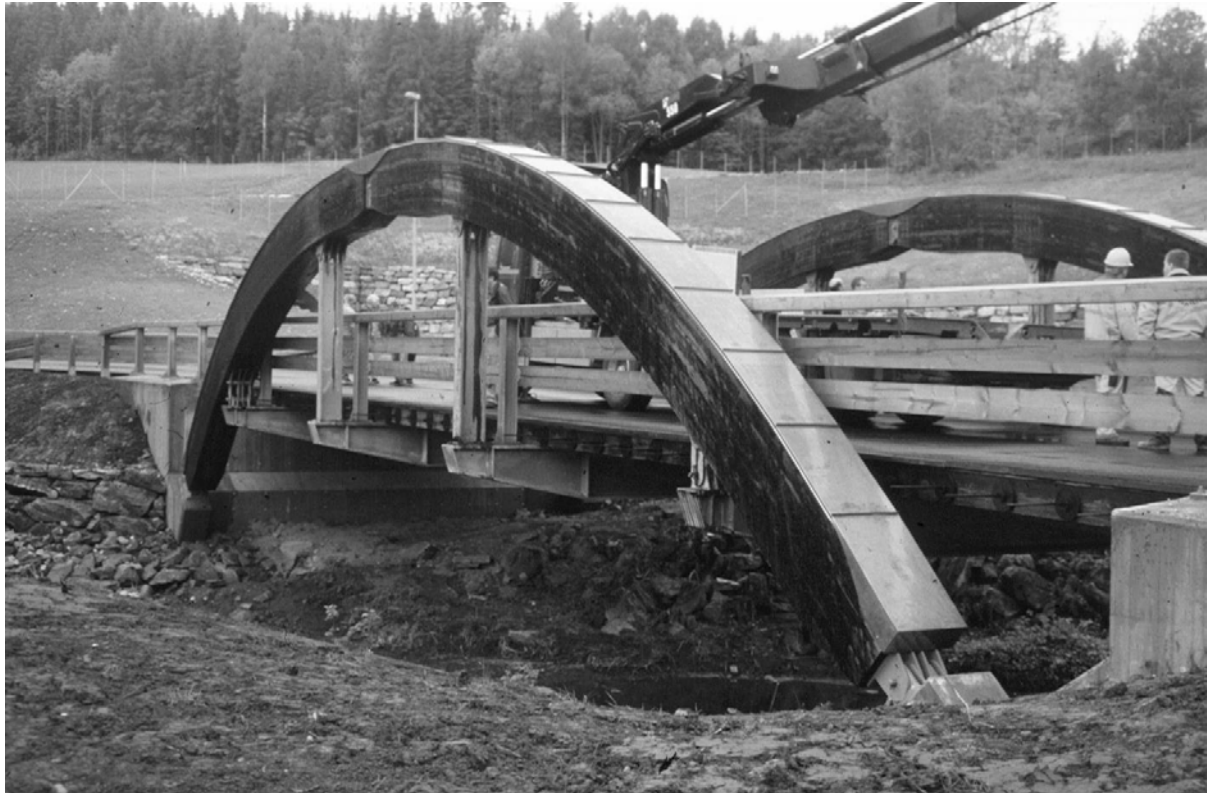
Bild 1: Bogenbrücke mit zwischenliegendem Fahrbahn
