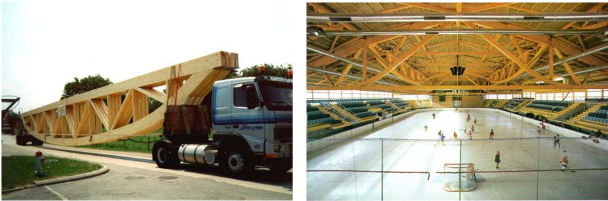
Abbildung 11 Fachwerke mit 45 und 36 Metern (Eishalle in Lausanne)
