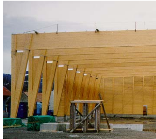
Abbildung 13 a) 30 m. Rahmen b) Rahmenecke für Träger mit einer Gesamtlänge von 42 m. und Gesamthöhe von 2.00 m.
