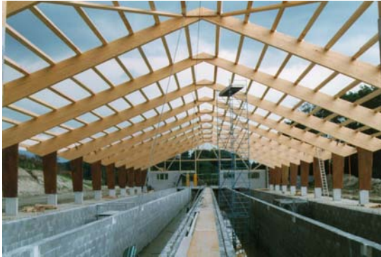
Abbildung 13 a) 30 m. Rahmen b) Rahmenecke für Träger mit einer Gesamtlänge von 42 m. und Gesamthöhe von 2.00 m.
