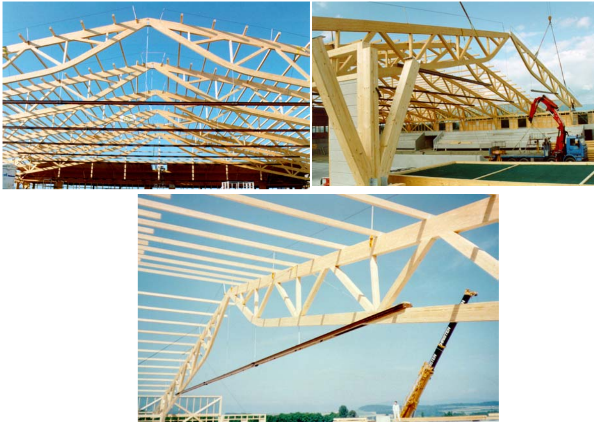
Abbildung 12 Fachwerke mit 56.6 m. Spannweite, Gesamtlänge 80 m. (IENA, Avenches)
