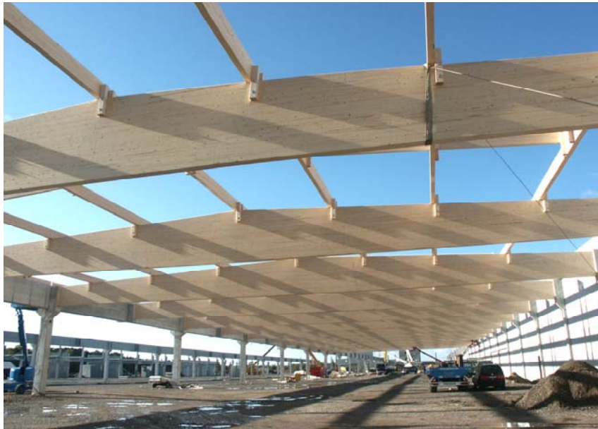
Abbildung 2: 1. Schiff Halle Großkunden während der Montage
