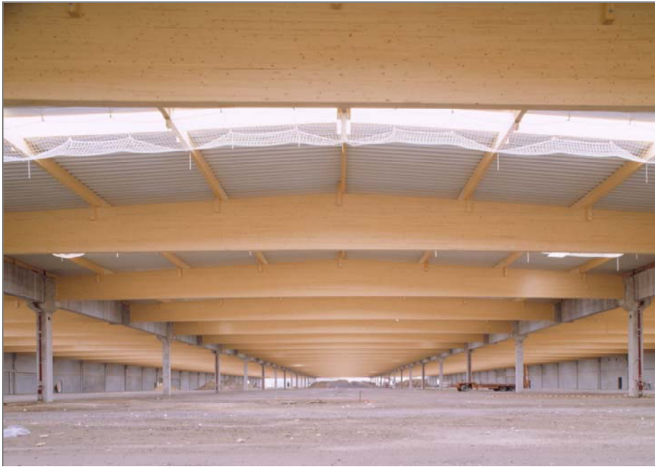
Abbildung 5: Mittelschiff Hauptkundenhalle 3 X 36,50 X 330,00 m
