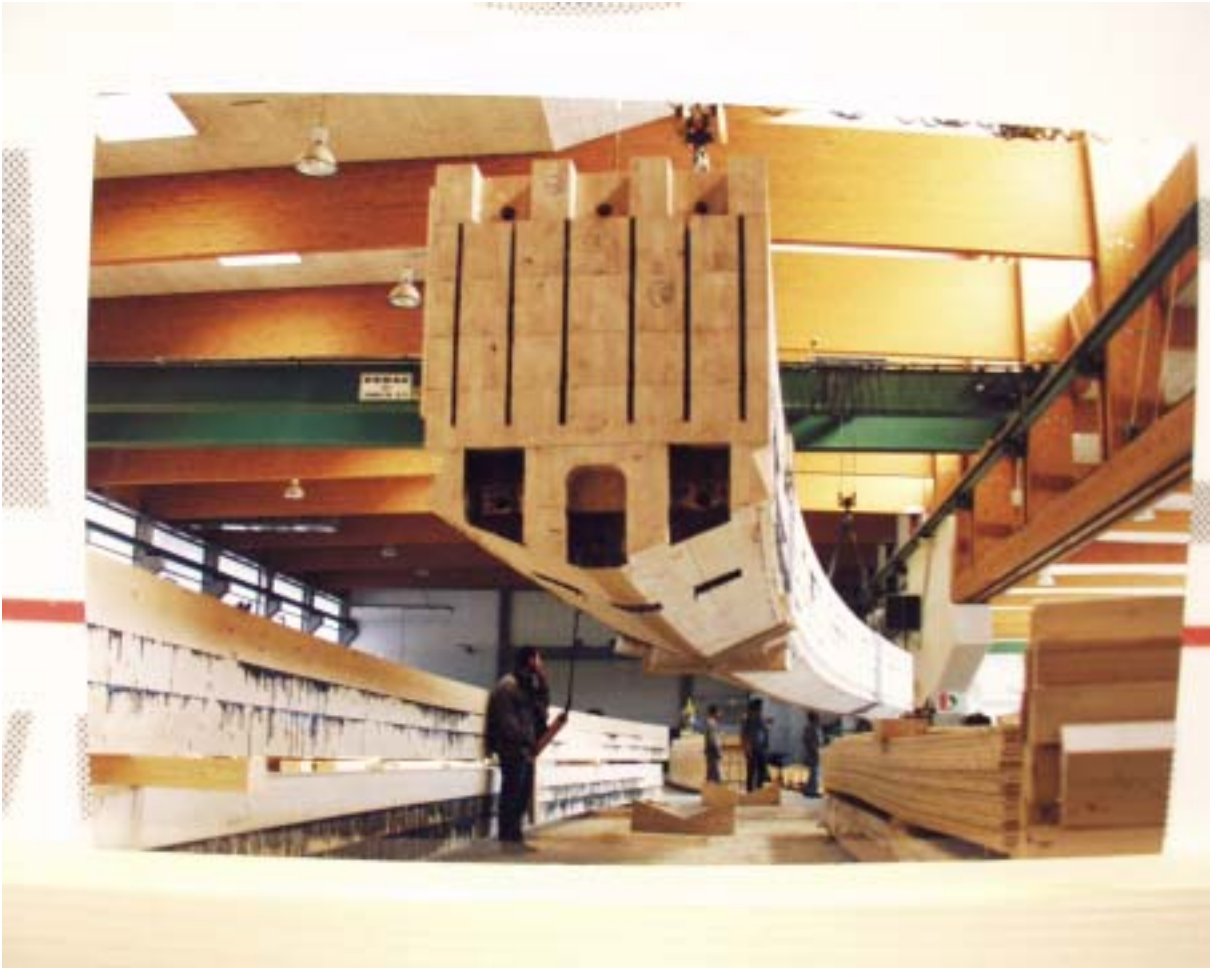
Abb. 6: Mittelträger Schibrücke Katschberg
