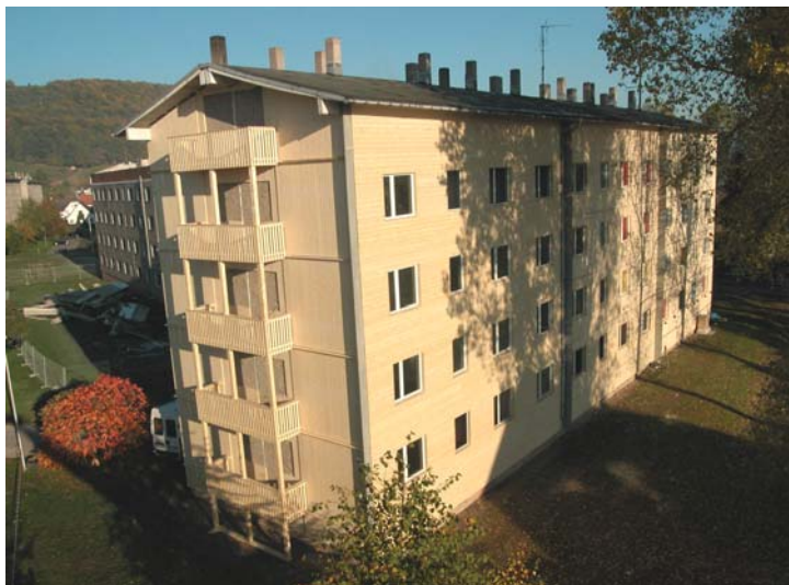
Abbildung 8: Versuchsgebäude in Merkers; mit Holz verkleidet
