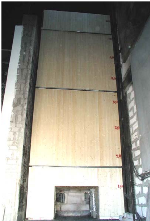
Abbildung 7: Prüfkörper fertig montiert
