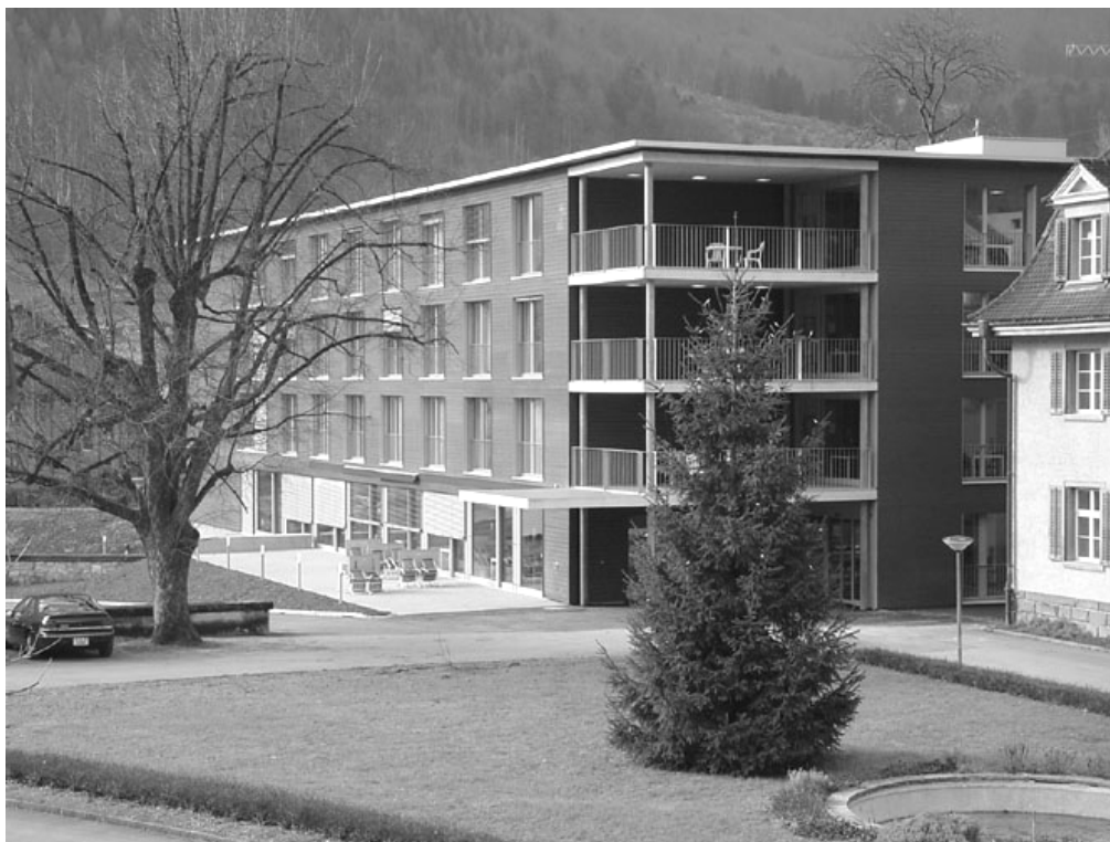
Abbildung 1: Holz-Aussenwand an einem Altersheim in Glarus
