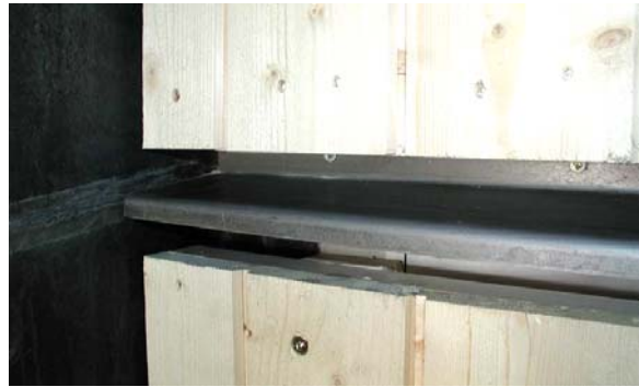
Abbildung 6: Detailaufnahme der Blechschräge
