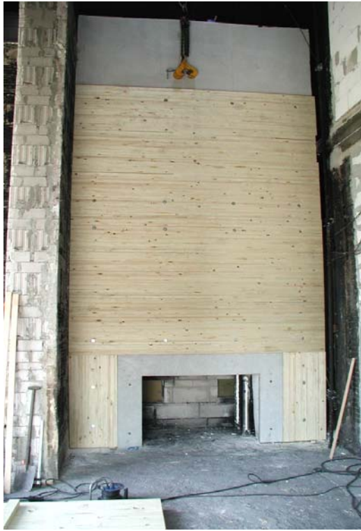
Abbildung 4: Unterkonstruktion mit teilweise montierter Holzplatte
