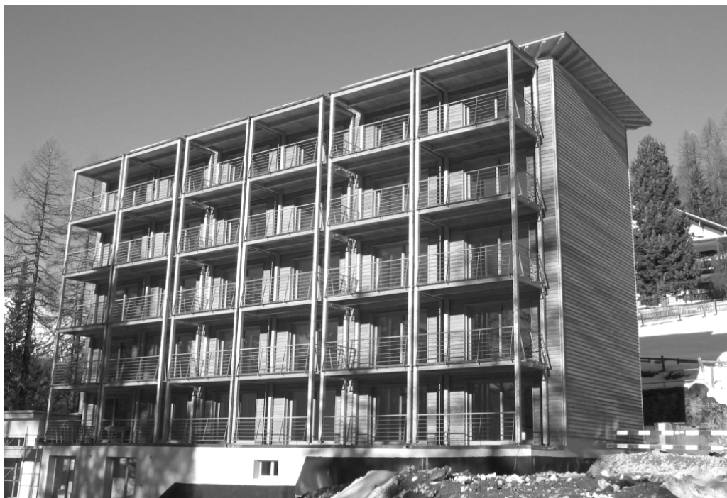
Abbildung 6: Mehrgeschossiges Gebäude mit Holzverkleidung in Davos
