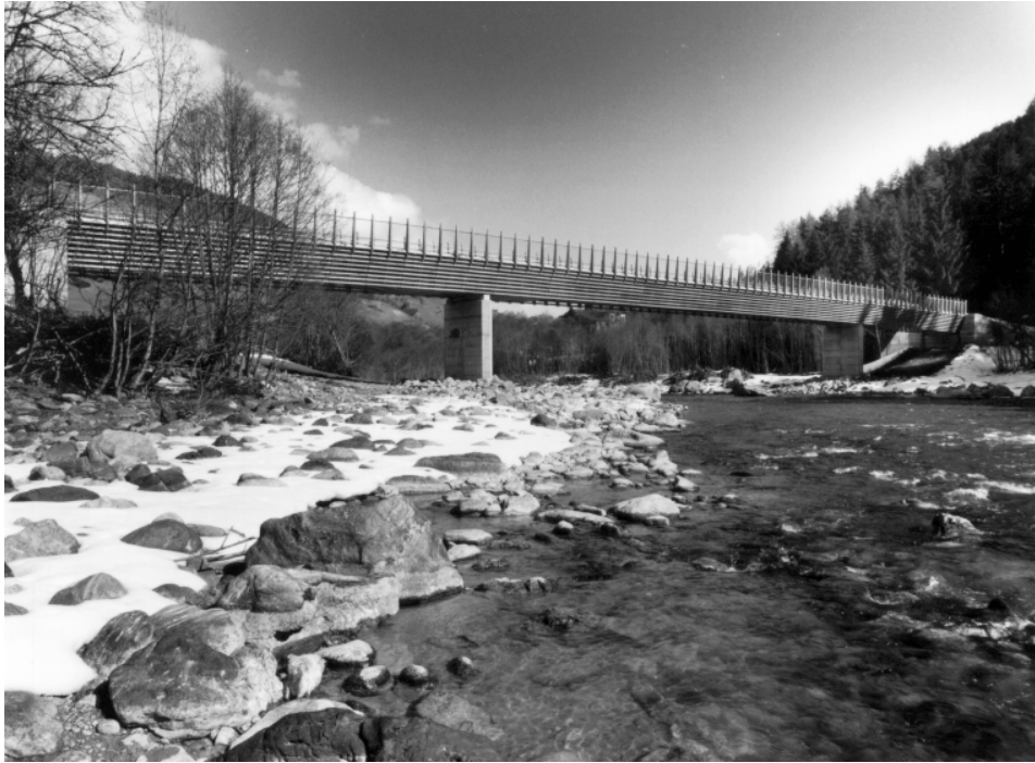
Bild 3 Langlaufbrücke Pradella, Scuol
