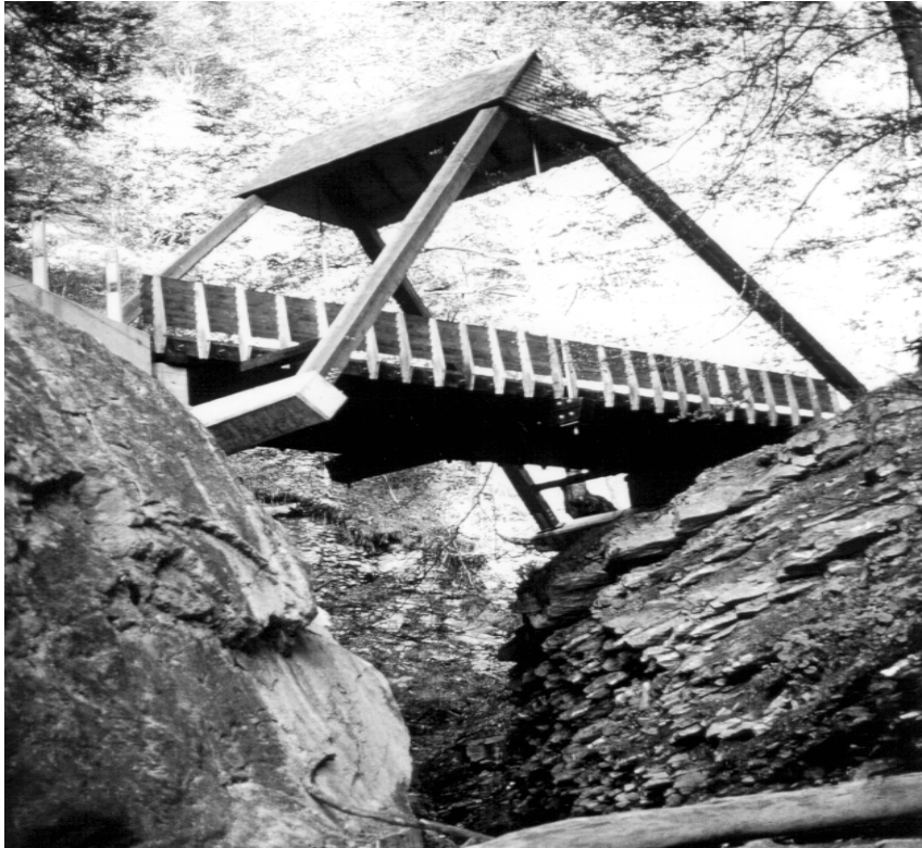
Bild 1 Schraubach -Brücken, Schiers
