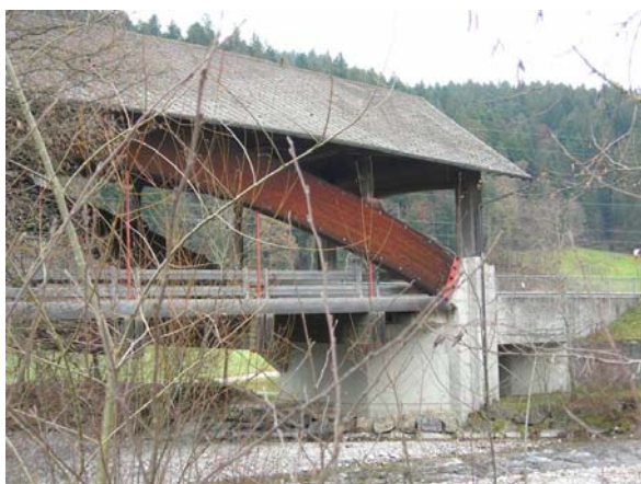
Abb. 1.1: Holzbrücke mit Stahlbeton-Widerlager
