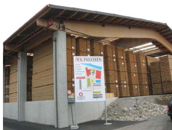
Abb. 1.2: Lagerhalle mit Holzträgern und Betonstützen
