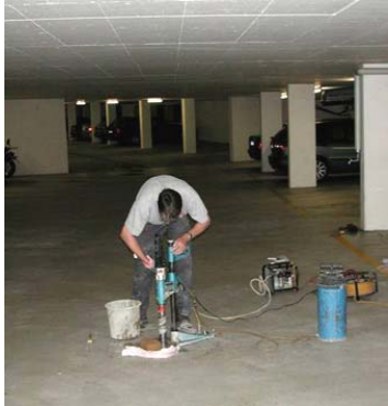
Abb. 3.6.1: Bohrkernentnahme aus Bodenplatte
