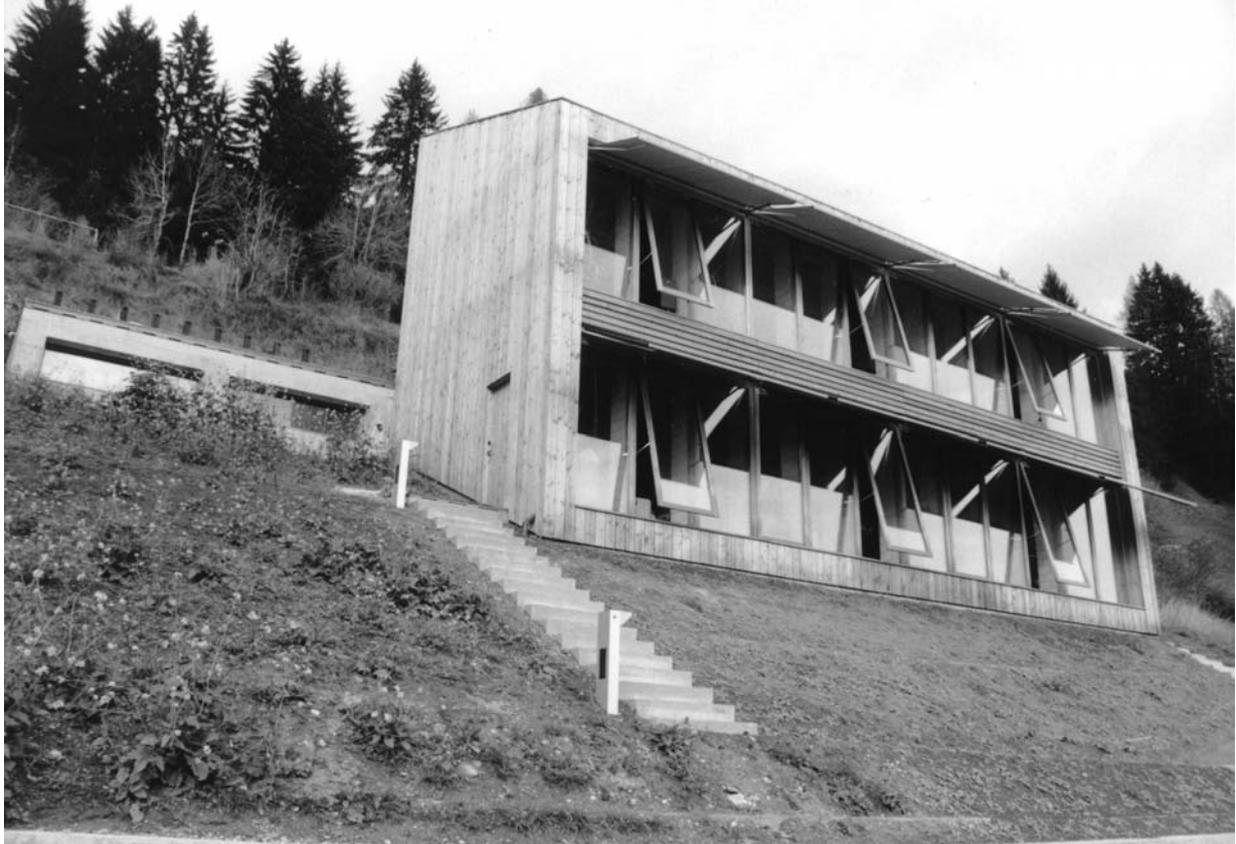
Mit dem „Messprojekt Direktgewinnhaus Trin“ ( erhältlich bei : HBT Solararchitektur, ETH Höggerberg, 8093 Zürich ) konnte bewiesen werden, dass ein Direktgewinnhaus ohne jede Heiz- oder Belüftungstechnologie problemlos bei sehr gutem Konfort funktioniert. Eine Ersatzluftanlage benötigt das Haus nicht, da die Sonnenenergie-Gewinnüberschüsse ( siehe unten ) derart gross sind, dass ein grosszügiges Fensterlüften fast jederzeit möglich ist.
