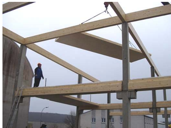
Abbildung 14: Montage der Deckenelemente
