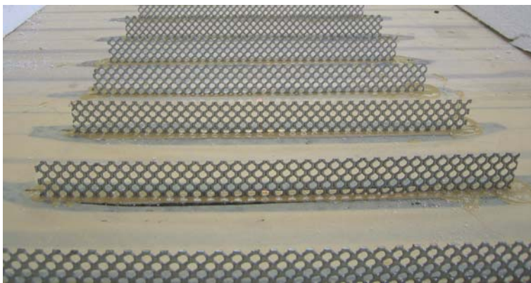
Abbildung 5: HBV - Schubverbinder
