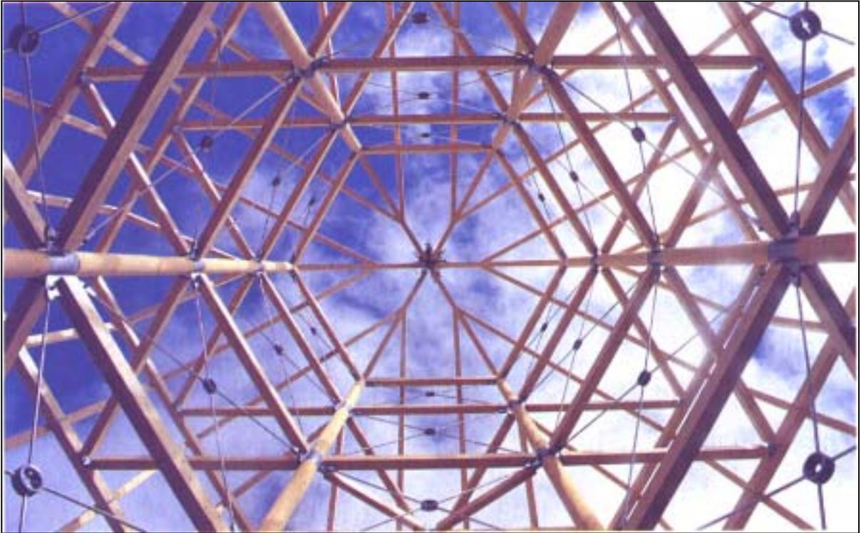
„Der Kristall“ – Primärkonstruktion nach Montage von unten
