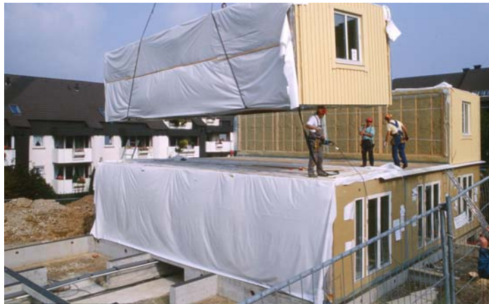
Abbildung 11: Montage der Container
