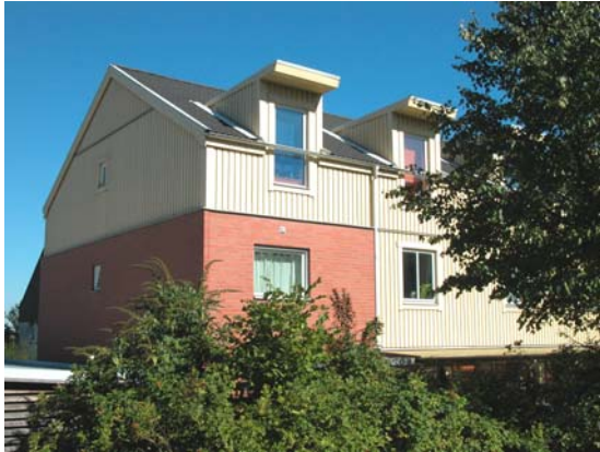
Abbildung 14: nach der Fertigstellung
