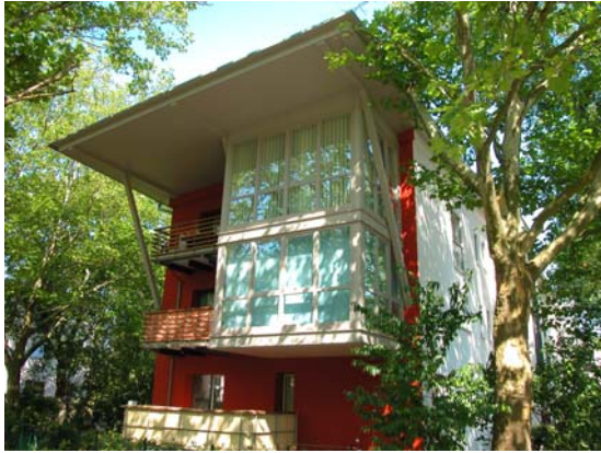
Abbildung 21: Berlin Britz Wohnanlage Neumarkplan
