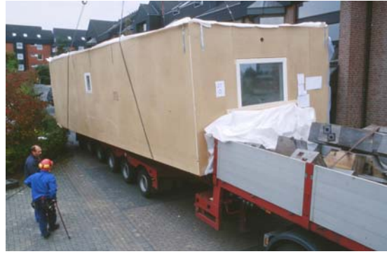
Abbildung 9: Anlieferung der verpackten Hausmodule
