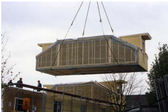
Abbildung 12: Montage des Dachgeschosses
