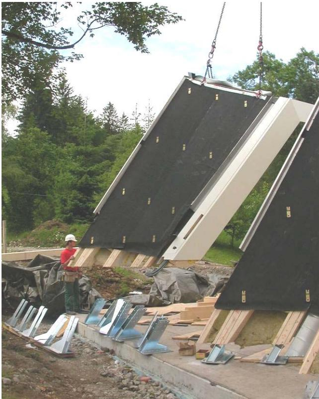
Abbildung 25-26: Transport und Montage der vormontierten Bügel
