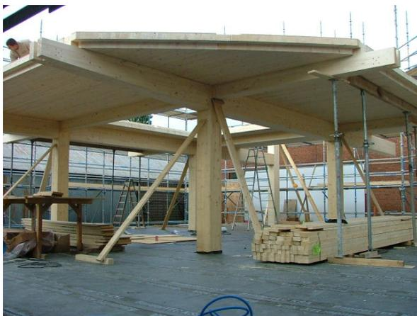
Abbildung 6: Zwischengeschoss EG montiert
