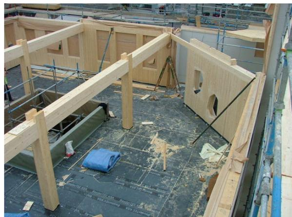
Abbildung 7: 1. Obergeschoss vor der Montage der Brettstapeldecke. Sichtbar sind das Primärtragwerk, die Aussenwände und die wasserdichte Folie der Decke.
