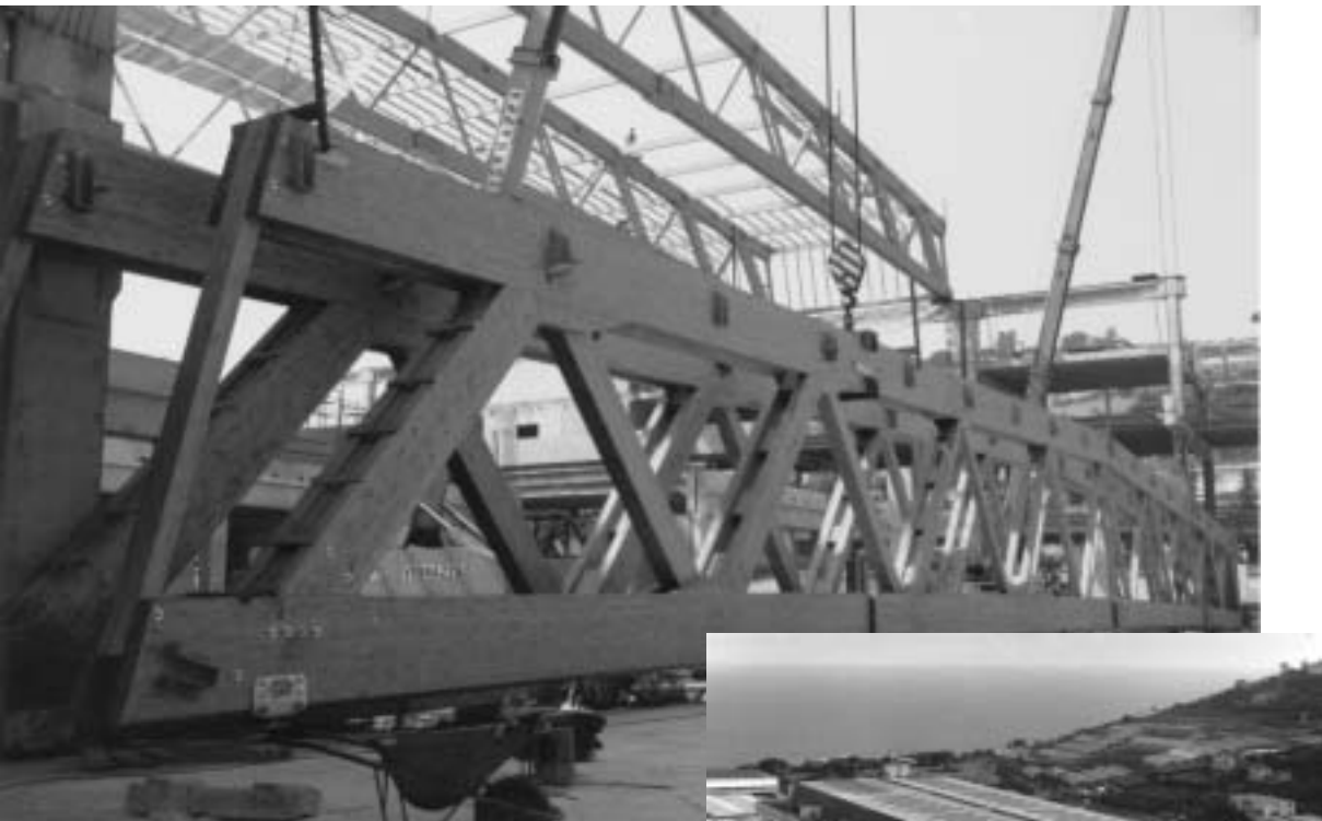
ÜBERDACHUNG DER BLUMENGROSSMARKTHALLE IN SAN REMO – 72 METER SPANNWEITE (1983)
