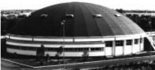
SPORTHALLE TORRICELLA BEI TARANTO 42 METER SPANNWEITE
