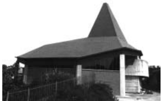
KIRCHE HEILIGE MARIA VON TAIGI BEI SIENA. RAUMLICHES FACHWERK MIT 29x34 METER SPANNWEITEN (1980).
