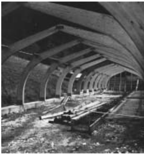
Sperimentelle Dachkonstruktion einer Almhütte (1967.) Spannweite 8 Meter.
