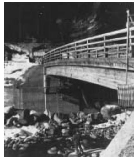
Sperimentelle Brückenkonstruktion (1970). Spannweite 18 Meter.
