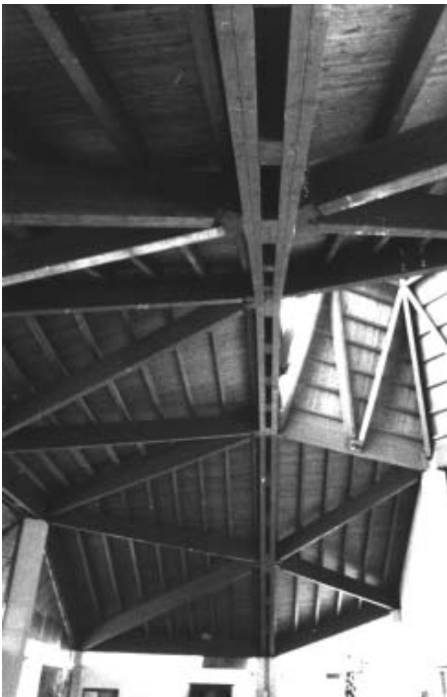
KIRCHE HEILIGE MARIA VON TAIGI BEI SIENA. RAUMLICHES FACHWERK MIT 29x34 METER SPANNWEITEN (1980).
