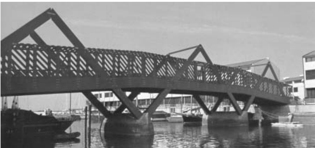
STRASSENBRÜCKE ÜBER EINEN HAFENKANAL BEI LIGNANO SABBIAORO (1979).
