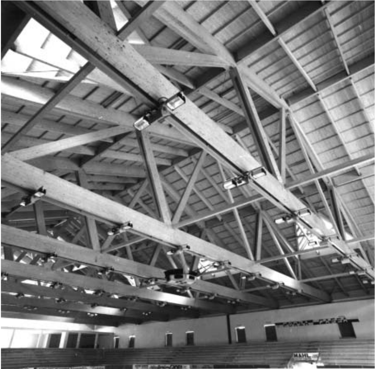
EISSPORTHALLE IN DEN DOLOMITEN BEI CANAZEI – SPANNWEITE 52 METER (1983)
