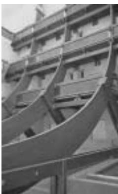
ANBAU EINER BALKONKONSTRUKTION AN EIN HOTEL AN DER ADRIATISCHEN KÜSTE
