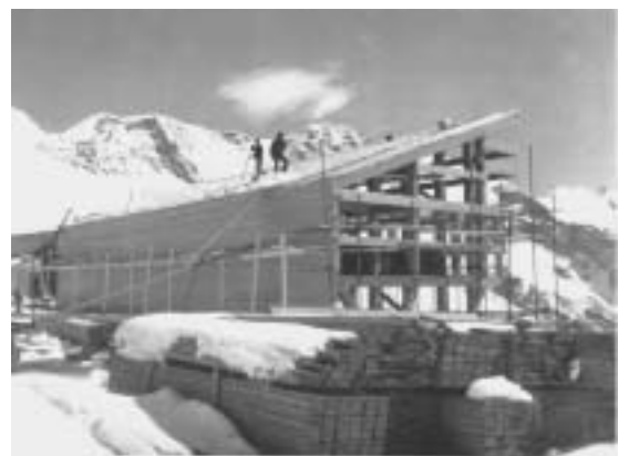
BAU EINER BERGHÜTTE 3585 METER ÜBER DEM MEHRESSPIEGEL AUF DEM MONTE ROSA
