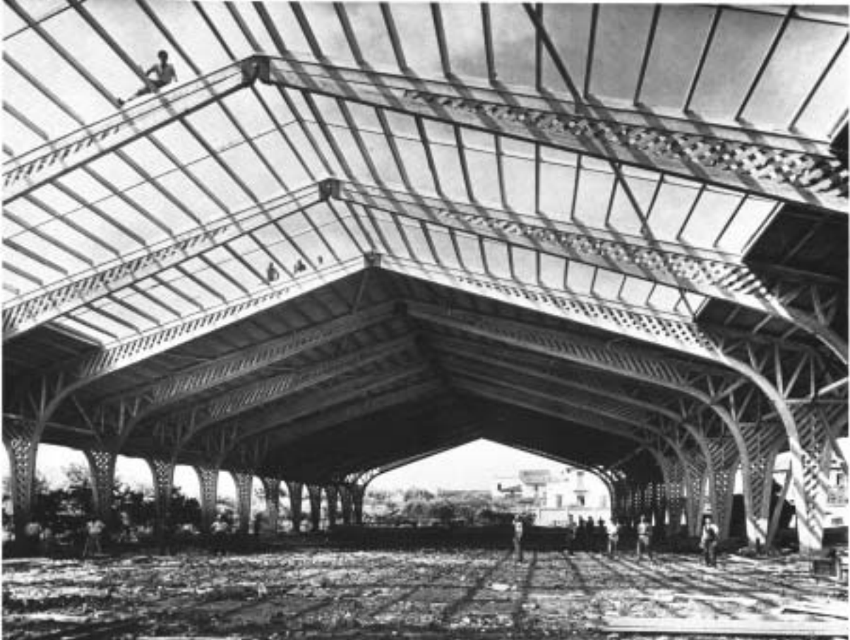
Industriehalle in Brescia um 1939 erbaut. Dreigelenkbogen mit 30 Meter Spannweite und beidseits 4 Meter Auskragung, Hauptträger in Fachwerkweise mit Nagelverleimte Ober- und Untergurte und kreuzweise verlegte Stegbretter. Struktur Ing. Bettoni und Bau Ing. Pasotti
