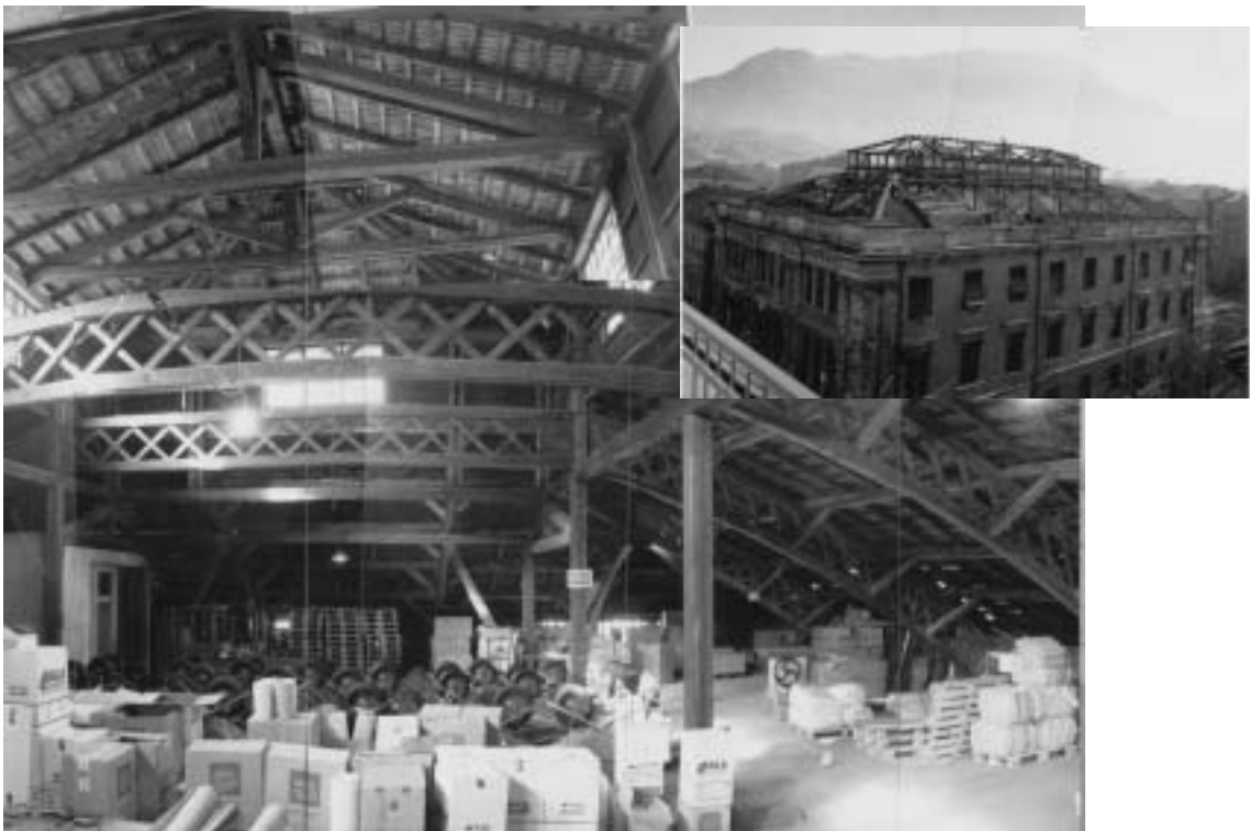
Dachkonstruktion eines Gebäudes der Zucht und Aulese der Seidenraupe bestimmt, in der Stadt Trient erbaut, vermutlich Anfang des Jahrhunderts. Gemischte Bauweise mit Stützen und Nebenträger aus Vollholz, Hauptträger in Fachwerkweise mit Nagelverleimteober- und Untergurte und kreuzweise verlegte Stegbretter. Diese Konstruktion wurde im Jahr 1990 renoviert und zu Universitätsräume umgebaut. Die Dachkonstruktion ist demontiert, verstärkt und neu zu seiner Funktion eingebaut worden.
