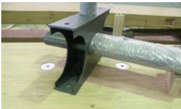
Abbildung 10: Auflagerbefestigung
