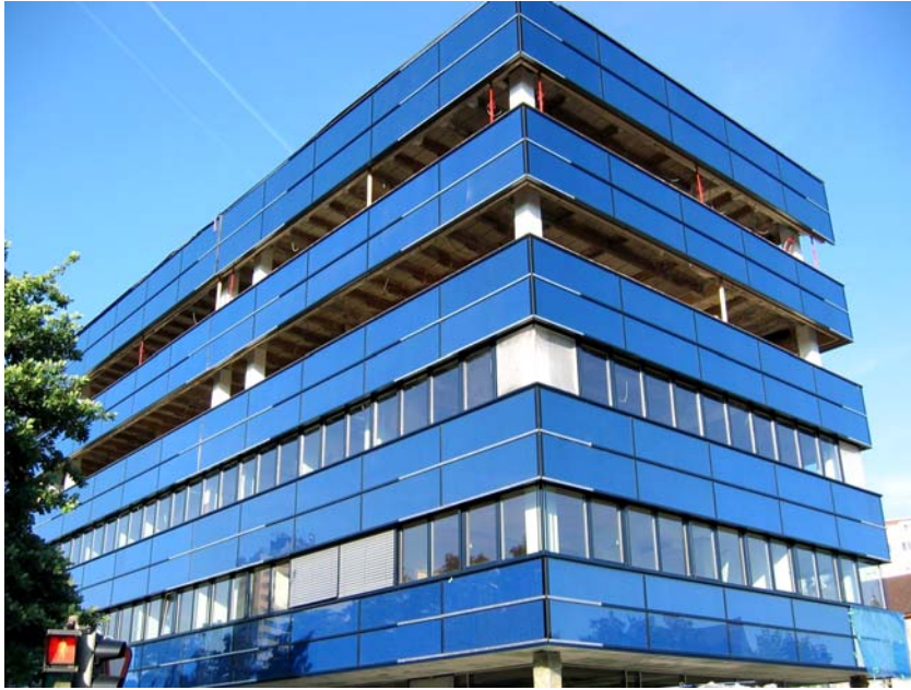
Abbildung 4: Sanierung eines Bürogebäudes in Linz mit hochvorgefertigten Holzelementen
