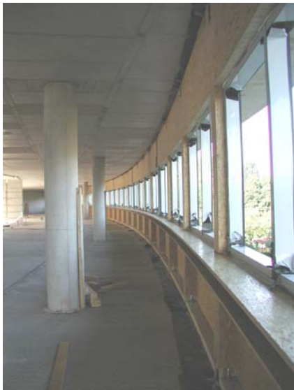
Abbildung 3: Anschluss der Holzelemente an die mineralische Struktur
